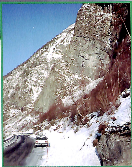
Riksveg 651 langs Austefjorden går med ei storblokkig ur ovanfor vegbana, og deretter ei bratt fjellside ovanfor ura.
