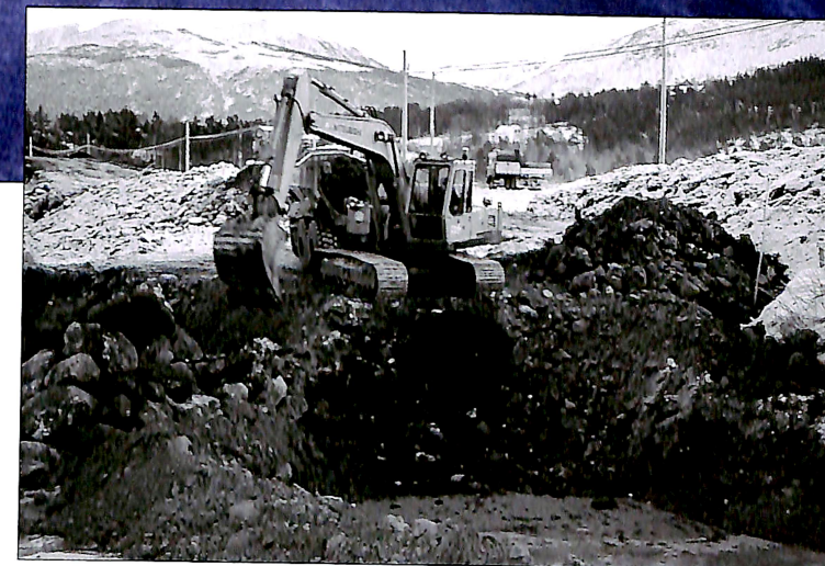
Hele prosjektet er i egenregi. Så lenge bruarbeidet pågår vil vi ha 6-7 mann i arbeid.
