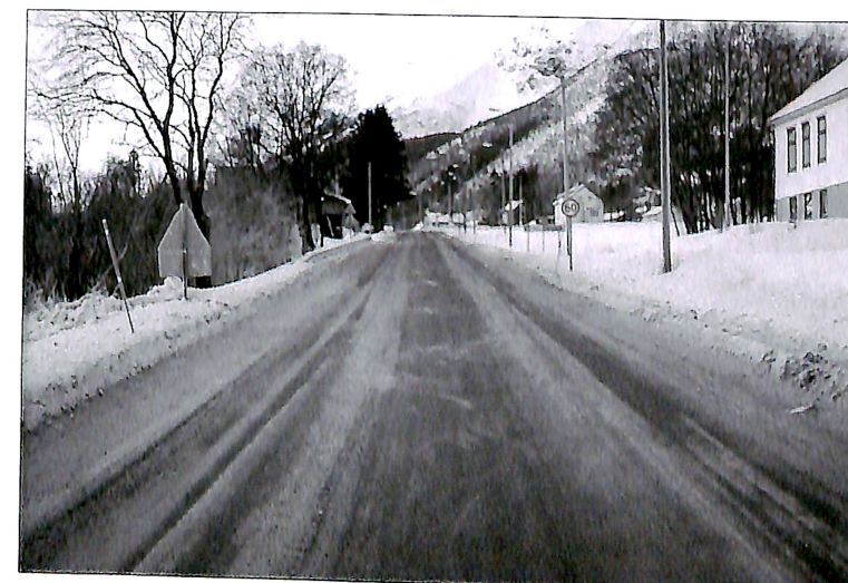
Det skal bygges 670 meter ny gang- og sykkelveg.
