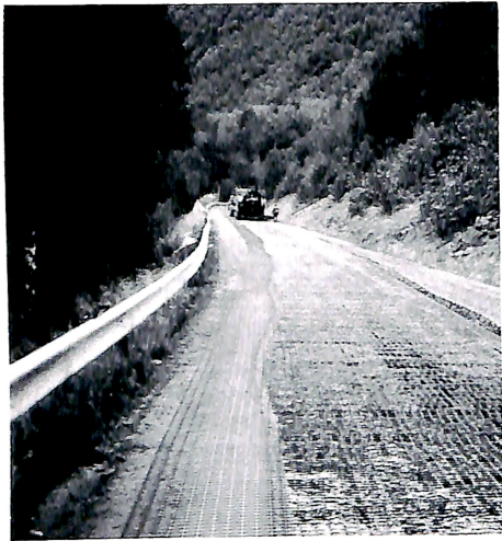
Ny type dekkearmeringsnett er forsøkt på Rv.063 i Valldal.
