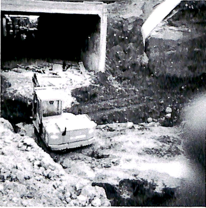
Planering for vingemurer og drenering sikring av siltig masse.
