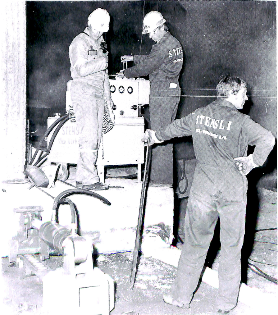
Det har gått bra, så langt. Sju teflonbrikker har passert. Oddbjørn Pladsen held kontakten med Trygve Vestad på andre sida kulverten.
