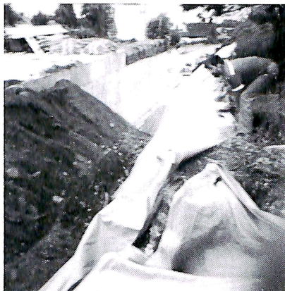
Det legges duk mellom drenerende masser og jordbakken (Vågsæter).
