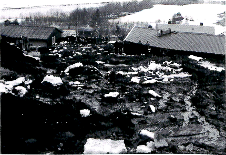
Utsyn frå bakkant av rasgropa. Merk bekkefara frå «oppkomer» i botnen av rasgropa.
