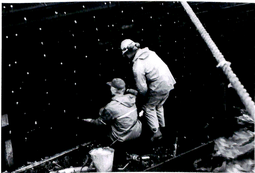
Elias Ræstad og Ole Misund i arbeid med fastskruing av plastplanker på Festøy ferjekai.
