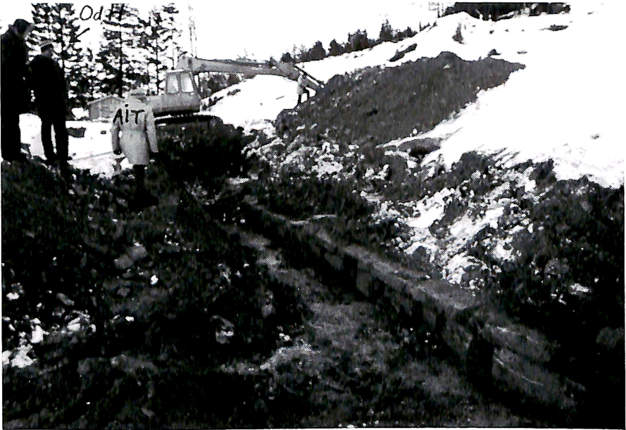
Fig. 6. Frå utgravinga av mur ved fyllingsfot. Raset tok med seg det øverste steinskiftet. Dette viser at brotflata ikkje gjekk ned i opphavleg grunn.
