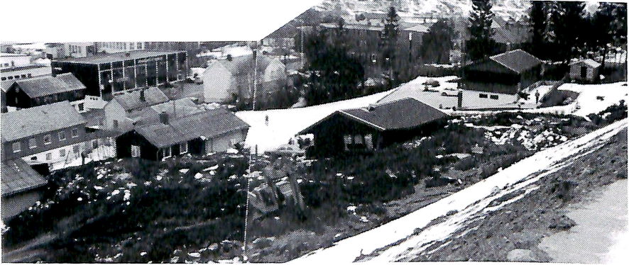
Fig. 4. Oversikt over området som var dekt av rasmasse. Volumet av utglidd masse er berekna til ca. 2.500 m 3 .
