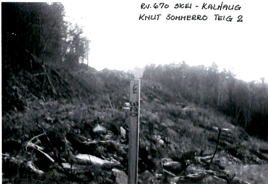
Fig. 1. Opphavleg terreng på sjølve rasstaden.
