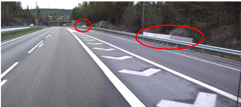
Figur 2: Ut plassering av midtdelelementer type Secura N2 langs E6 (Foto fra 2008)
