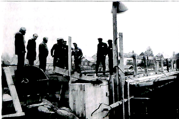
Fra støpearbeidet på Akersvika
