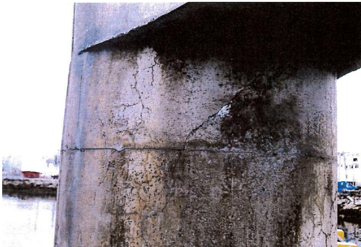
Figur 5.2: Skråriss i søyle under tverrbjelke [4]
