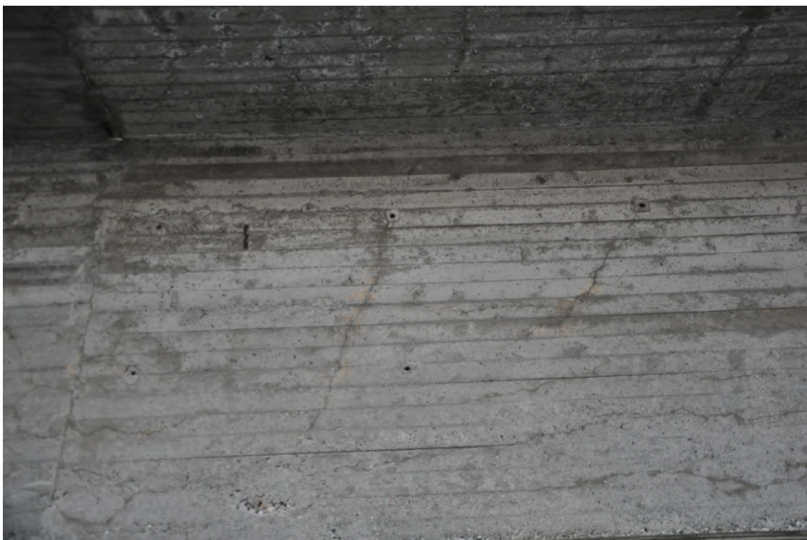
Figur 5.7: Skråriss i bjelken
