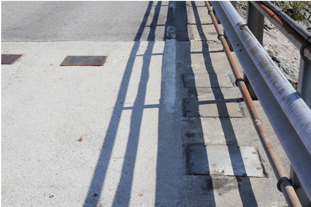
Figur 6.13: Inspeksjonsluke til fjellforankring
