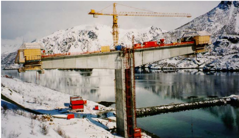
Figur 3.2: Balansert utbygging med forskalingsvogner [5]
