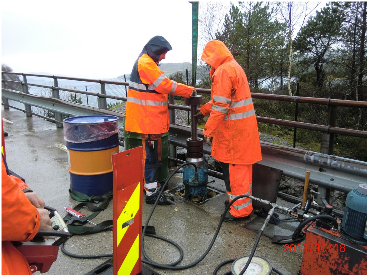
Figur 6.15: Prøvetrekking av fjellkabler
