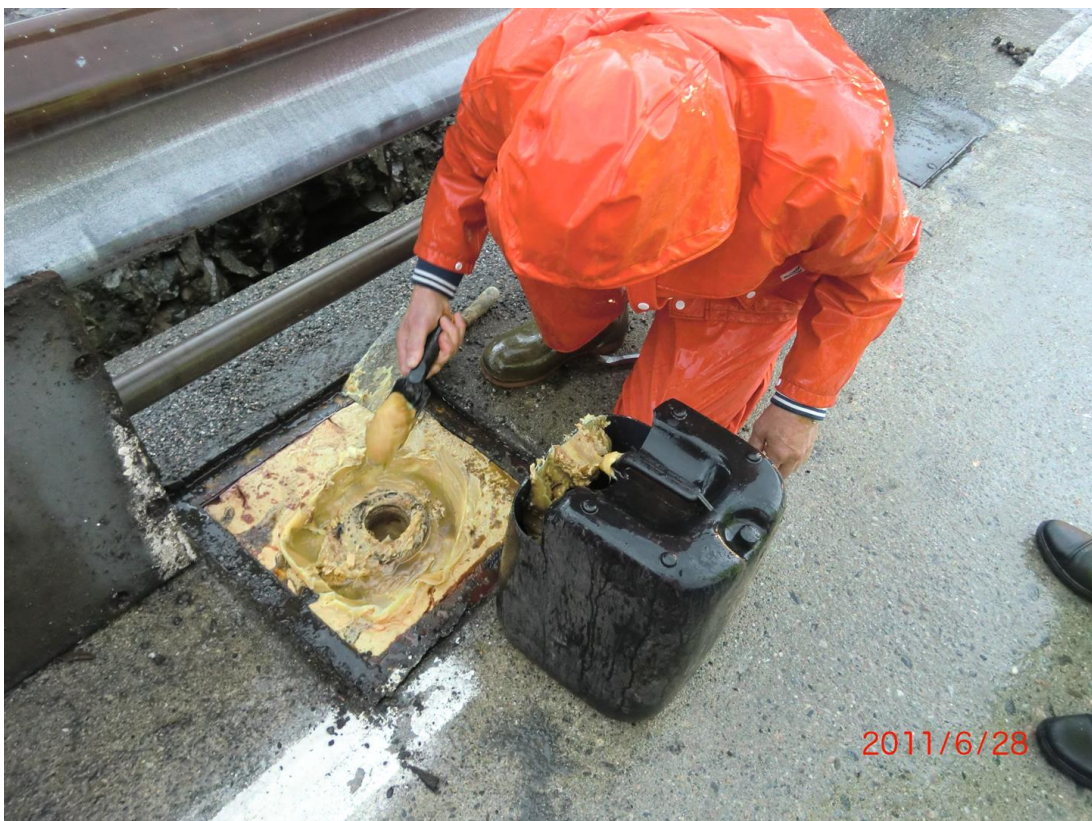
Figur 6.14: Fjellkabler innsatt med fett
