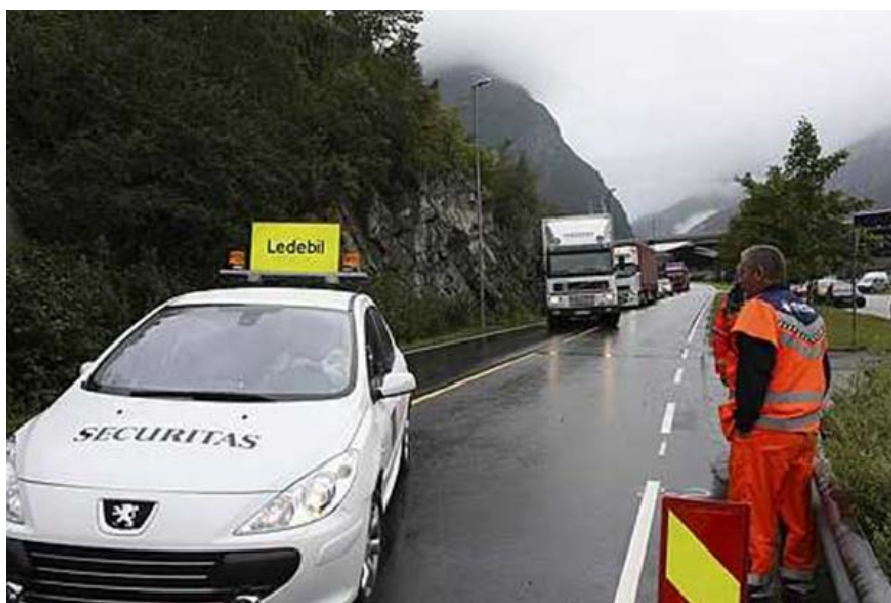
Figur 21.3 Bruk av ledebil ved rassikringsarbeid
