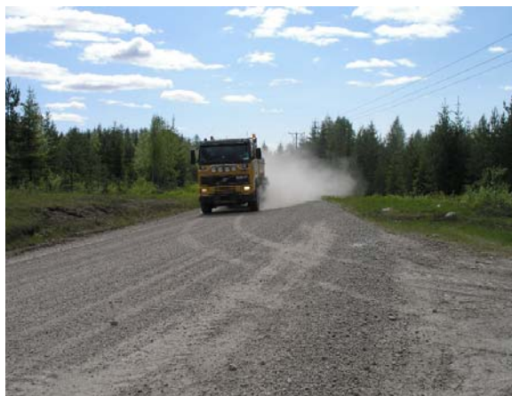
Figur 8.4 Støv fra grusveg. Til venstre alvorlighetsklasse 2, akseptabel tilstand. Til høyre alvorlighetsklasse 4, dvs umiddelbart behov for tiltak (Foto: Vägverket)
