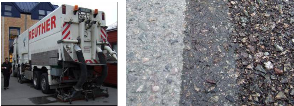
Figur 8.23 Vannjet (høytrykkspyler) for friksjonsforbedring. Ubehandlet og behandlet dekke. (Foto: Vegard Opsahl)
