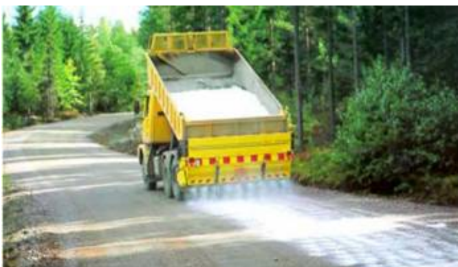
Figur 8.6 Støvbinding med kalsiumklorid. Utlegging med sandspreder
