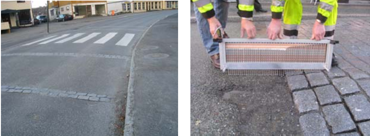
Figur 19.7 Opphøyd gangfelt med brosteinmarkering. Til høyre brostein farlig for brøyteskjær
