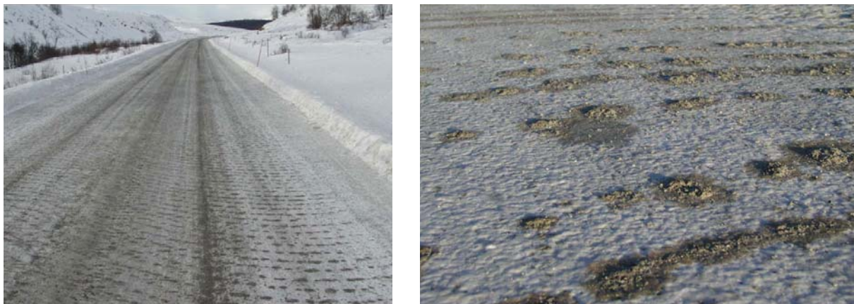
Figur 12.11 Strøing utført etter fastsandmetoden, oversiktsbilde og detaljbilde
