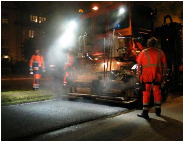
Figur 8.18 Utlegging av støysvake tynndekker (Ring 2 Oslo, Rv 170 Bjørkelangen). (Foto: Jostein Aksnes)
