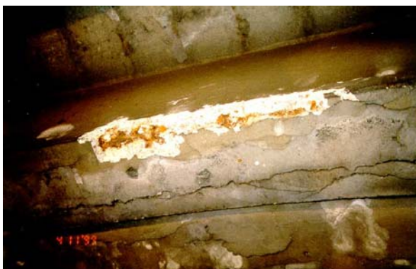
Figur 13.2 Eksempel på armeringskorrosjon initiert av klorider, før og etter fjerning av løs/delaminert betong
