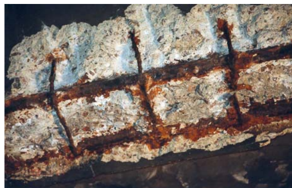
Figur 13.2 Eksempel på armeringskorrosjon initiert av klorider, før og etter fjerning av løs/delaminert betong
