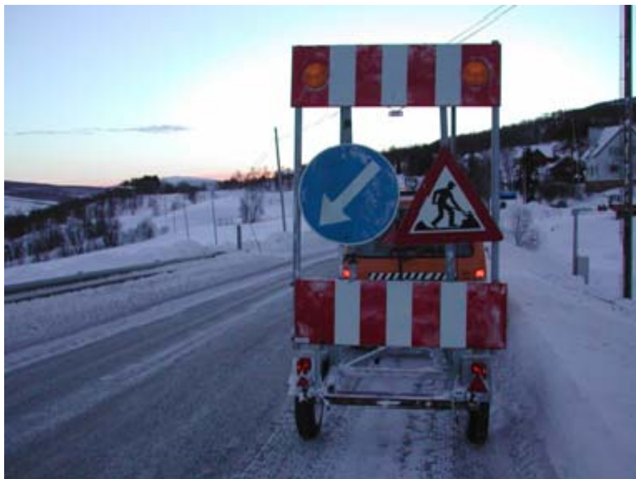
Figur 21.7 Arbeidsvarsling må gjennomføres etter retningslinjene
