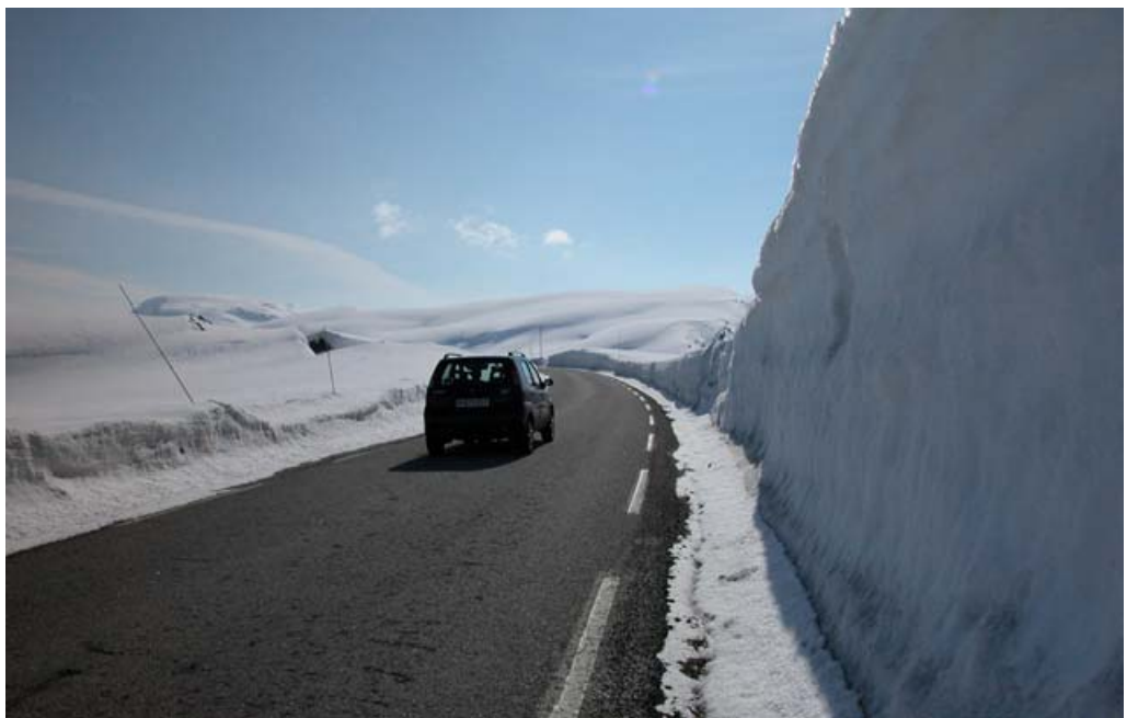
Figur 22.5 Høye brøytekanter kan være et problem for viltet som skal krysse vegen. Viltet vil bruke lenger tid på å krysse vegen og brøytekanterne kan dermed øke faren for viltpåkørsel. (Foto: Statens vegvesen)
