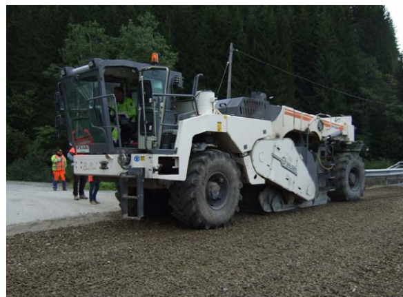
Figur 8.21 Eksempel på forsterkningstiltak; utlegging av ny bærelagspukk oppå gammelt dekke med påfølgende dypfresing til 25 cm dybde. (Foto: Vegard Opsahl)
