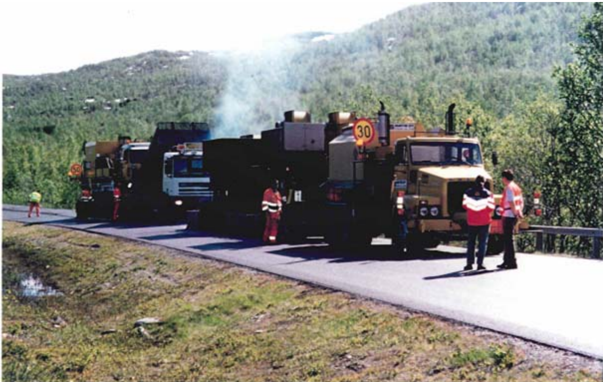
Figur 8.24 Varm gjenvinning på veg (Remix). (Foto: Geir Berntsen)
