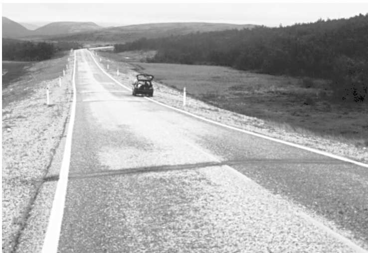
Figur 8.11 Tverrsprekker pga lavtemperatur, Finnmark (Foto: Eivind Andersen)
