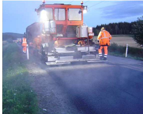
Figur 8.18 Utlegging av støysvake tynndekker (Ring 2 Oslo, Rv 170 Bjørkelangen). (Foto: Jostein Aksnes)
