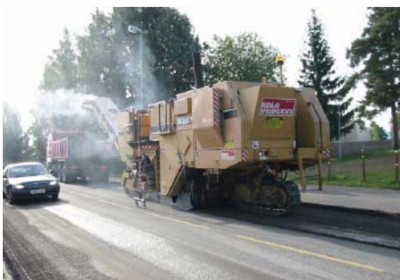
Figur 8.15 Asfaltfresing; traufresing (til venstre) og planfresing (til høyre). (Foto: Arvid Jordet)
