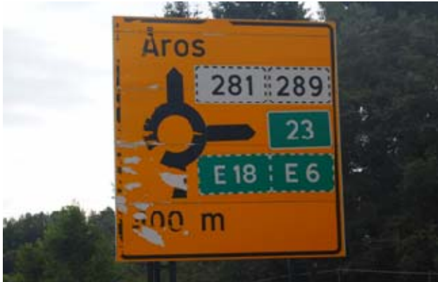
Figur 16.5 Skilt som er skadet
