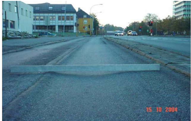
Figur 8.8 Sporete og deformerte asfaltdekker finner vi både utenfor og i tettbygd strøk
