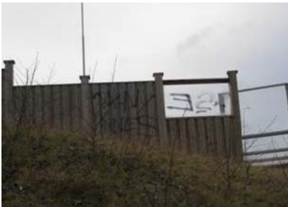
Figur 19.5 Støyskjermer utsatt for tagging. Til høyre justerbart feste til fundament.
