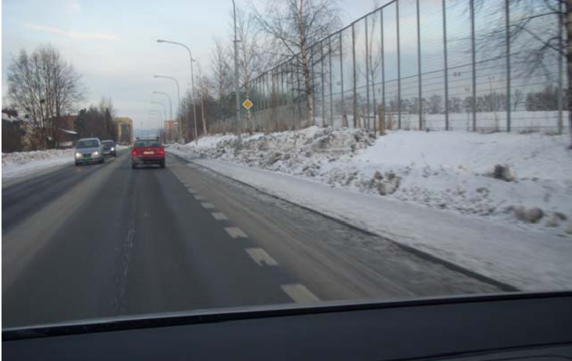
Figur 18.5 Snø fra kjørebanelen har lagt seg langs kantsteinen i sykkelfeltet
