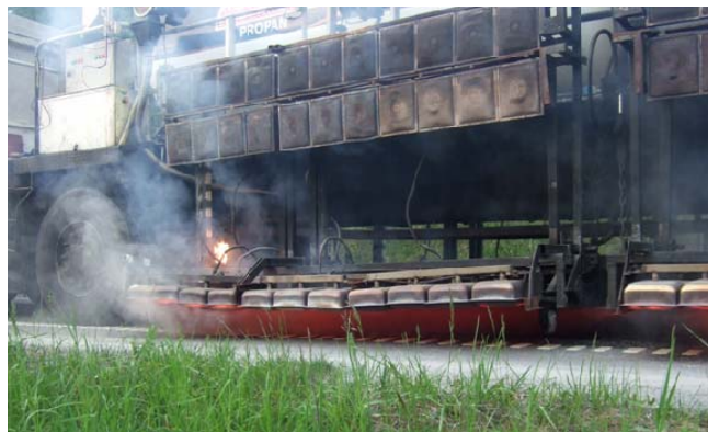
Figur 8.17 Forvarming før asfaltering (Foto: Vegard Opsahl)
