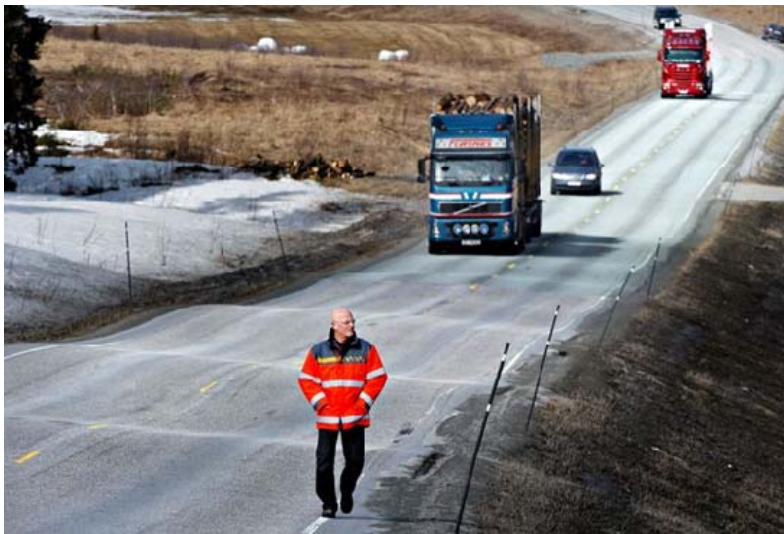
Figur 8.9 Ujevne grunn- og teleforhold kan forårsake store ujevnheter (Foto: Harald Sæterøy, Trønder-Avisa)
