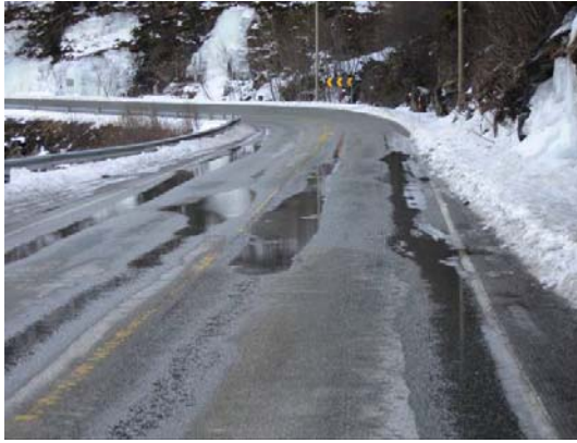
Figur 8.8 Sporete og deformerte asfaltdekker finner vi både utenfor og i tettbygd strøk
