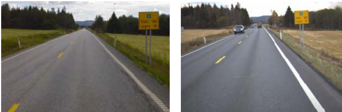
Figur 9.8 Kantforsterkning med stålarmoring på rv 4, Oppland – før (2007) og etter (2009) tiltak
