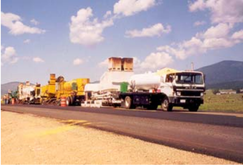
Figur 8.25 Varm gjenvinning på veg (Pyropaver). Legg merke til skorsteinene for avbrenning av røykgassene
