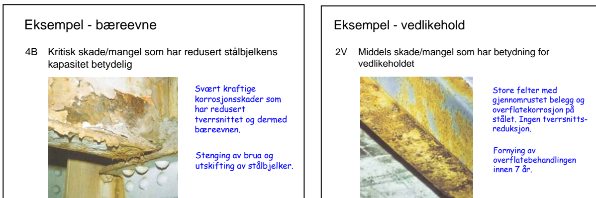
Figur 13.12 Eksempler på vurdering og klassifisering av skader på stål, med angivelse av skadegrad og skadekonsekvens (fra skadekatalogen i Håndbok 136)
