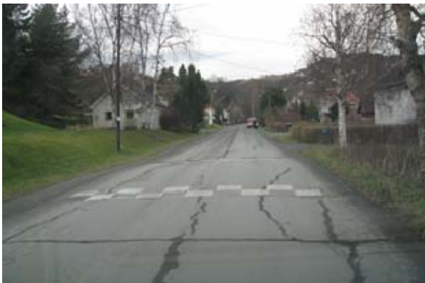
Figur 19.6 Fartshump markert med vegmerking. Til høyre fartspute.
