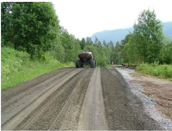
Figur 8.7 Støvbinding med lignin (Dustex). Utlegging med hhv gjødselspreder og tankbil
