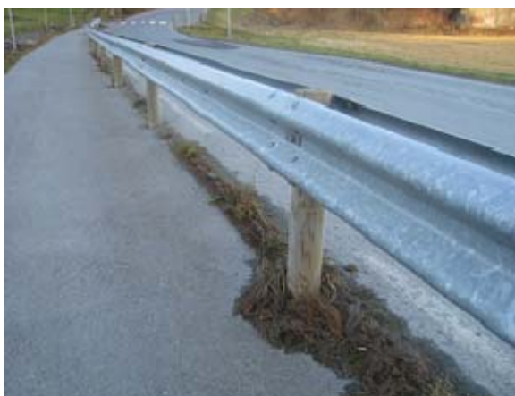
Figur 19.4 Rekkverk mellom kjøreveg og gang- og sykkelveg. Til høyre utbøyd rekkverk.
