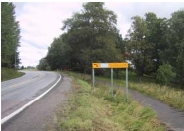
Figur 16.4 Skiltets folie er falmet og har så dårlig refleks at det ikke fungerer verken i dagslys eller mørke
