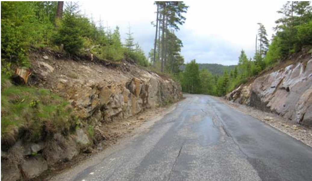
Figur 22.8 Berbyveien i Østfold er en mellomriksveg fra Unionstiden og ble anlagt i 1880 og inngår i Nasjonal verneplan for veger, bruer og vegrelaterte kulturminner. Den er fredet etter kulturminneloven. Det øverste fotoet viser vegen slik den så ut da vegen ble fredet. Det nederste fotoet er eksempel på utbedring der det har vært manglende kunnskap om vegens verneverdi. Det er viktig at kulturminnefaglig kompetanse vurderer hvordan hensynet til kulturminnet kan ivaretas før et såpass omfattende tiltak gjennomføres. I dette tilfellet hadde det vært mulig å utbedre vegen med mye enklere tiltak enn det som er gjennomført (vegetasjonsrensk, grøfting, utbedring av rekkverk etc). (Foto: Statens vegvesen, 1999 og 2011)
