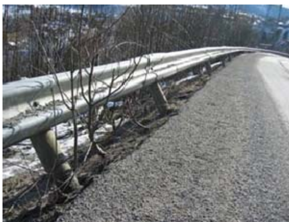
Figur 19.4 Rekkverk mellom kjøreveg og gang- og sykkelveg. Til høyre utbøyd rekkverk.
