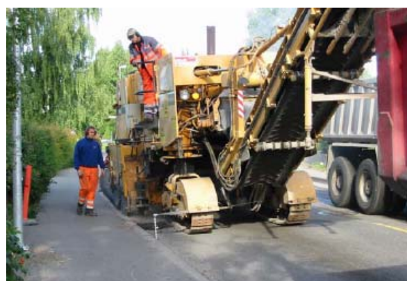
Figur 8.15 Asfaltfresing; traufresing (til venstre) og planfresing (til høyre). (Foto: Arvid Jordet)
