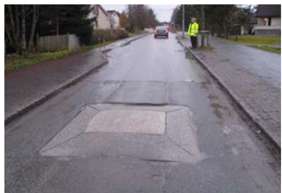
Figur 19.6 Fartshump markert med vegmerking. Til høyre fartspute.
