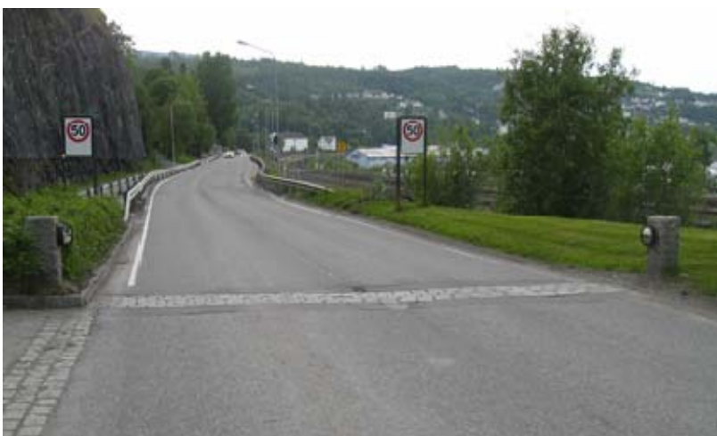
Figur 19.9 Ulike typer vegbelysning. Lyskilder nær vegbanen er utsatt for skader.
