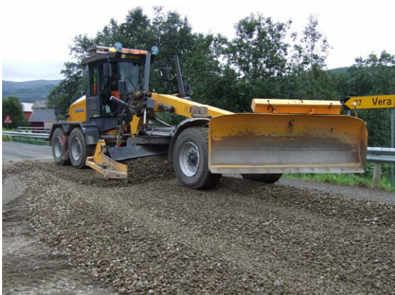
Figur 8.21 Eksempel på forsterkningstiltak; utlegging av ny bærelagspukk oppå gammelt dekke med påfølgende dypfresing til 25 cm dybde. (Foto: Vegard Opsahl)
