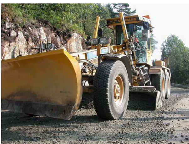
Figur 8.5 Høvling av grusveg
