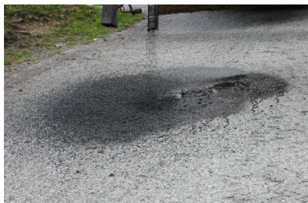
Figur 8.20 Lappekanon for reparasjon av hull (Mesta). (Foto: Noralf Haugvaldstad)
