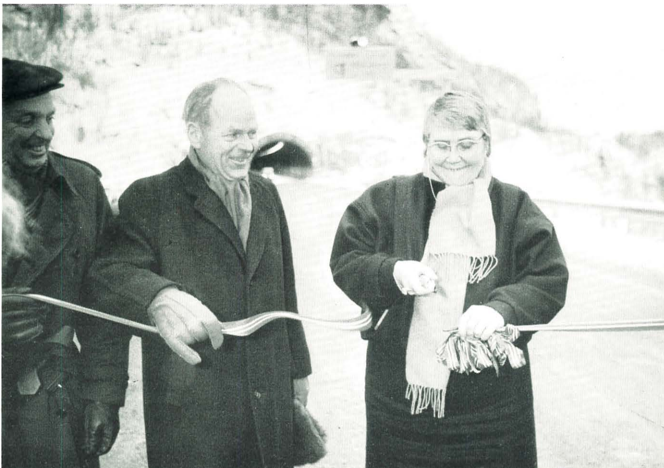
Den høytidelige åpningen av E 68, Sønsterud–Rørvik, ble foretatt av formannen i Stortingets samferdselskomité, Oddrunn Pettersen og vegdirektør Eskild Jensen. Foto: Ring. Blad.
