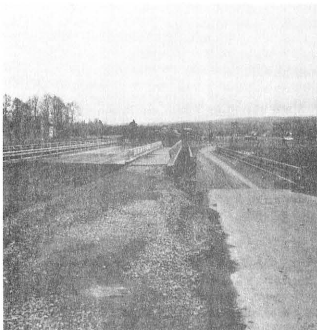
Ny Langebru bru ble åpnet i høst og kan nå passeres med 10 tonn akseltrykk.
