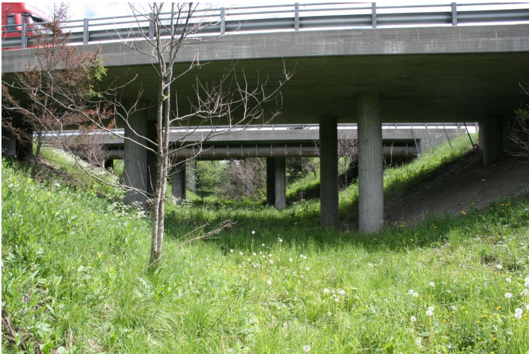
Figur 7: Klevjerhagen under E18 og jernbanen, Sande i Vestfold er et eksempel på en faunapassasje som er tiltenkt vilt men som ikke blir benyttet. Foto: Victoria Marie Kristiansen
