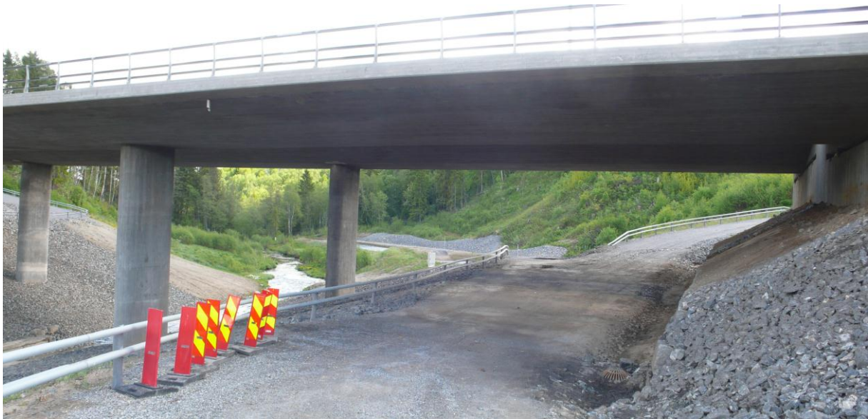
Figur 3: Eksempel på undergang som kan brukes som et sambruksformål for vilt og menneskelig aktivitet. Merk: undergangen er ikke undersøkt som en del av etterundersøkelsesprogrammet. Foto: Karianne Thøger-Andresen
