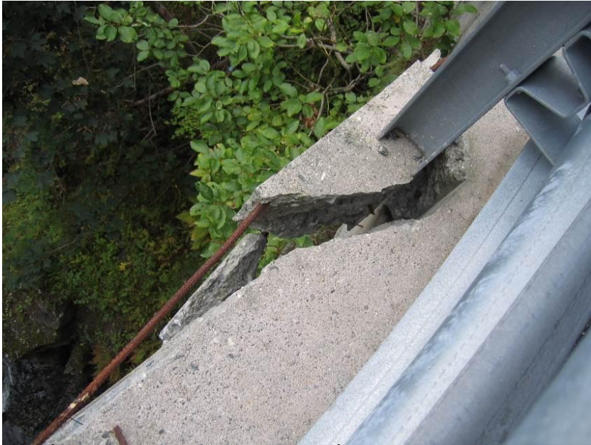
FIGUR 2 EKSEMPEL PÅ SKADET REKKVERKSINNFESTING PÅ BRU I REGION VEST (FOTO: STATENS VEGVESEN)
