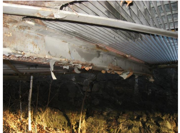
FIGUR 20 SKADE I OVERFLATEBEHANDLINGEN BJELKER OG TVERRBÆRER PÅ GANGBRU OVER E18 (FOTO: STATENS VEGVESEN)
