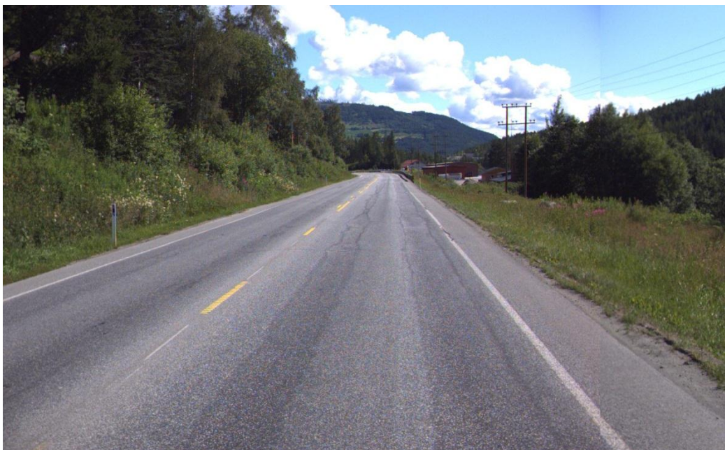
FIGUR 33 VEGDEKKE MED DYPE SPOR – RV 7 NÆR ÅL (FOTO: STATENS VEGVESEN)
