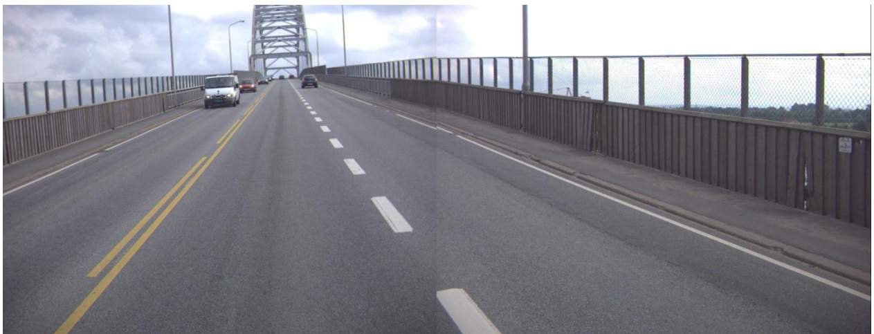
FIGUR 19 FREDRIKSTAD BRU PÅ RV110 (FOTO: STATENS VEGVESEN)
