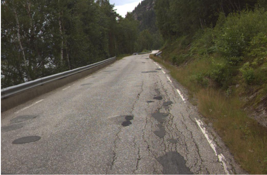
FIGUR 29 DÅRLIG VEGDEKKE GRUNNET SVAKT VEGFUNDAMENT – RV 41 VED NISSERVANN I TELEMARK (FOTO: STATENS VEGVESEN)
