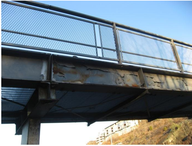
FIGUR 20 SKADE I OVERFLATEBEHANDLINGEN BJELKER OG TVERRBÆRER PÅ GANGBRU OVER E18 (FOTO: STATENS VEGVESEN)
