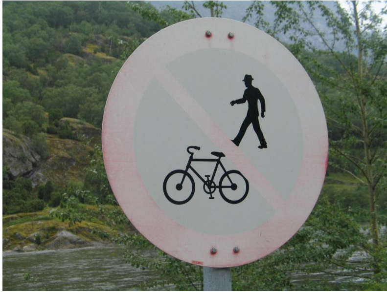
FIGUR 11 EKSEMPEL PÅ FORFALL AV SKILT – FALMET SKILTPLATE (FOTO: STATENS VEGVESEN)
