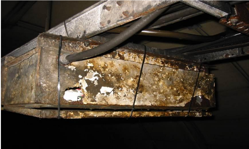
FIGUR 36 LYSARMATUR I FLØYFJELLSTUNNELEN (E39) I BERGEN (FOTO: STATENS VEGVESEN)
