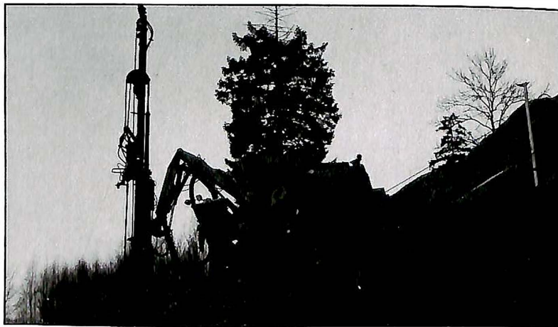
Arbeidet er startet på Sjølinjen.
