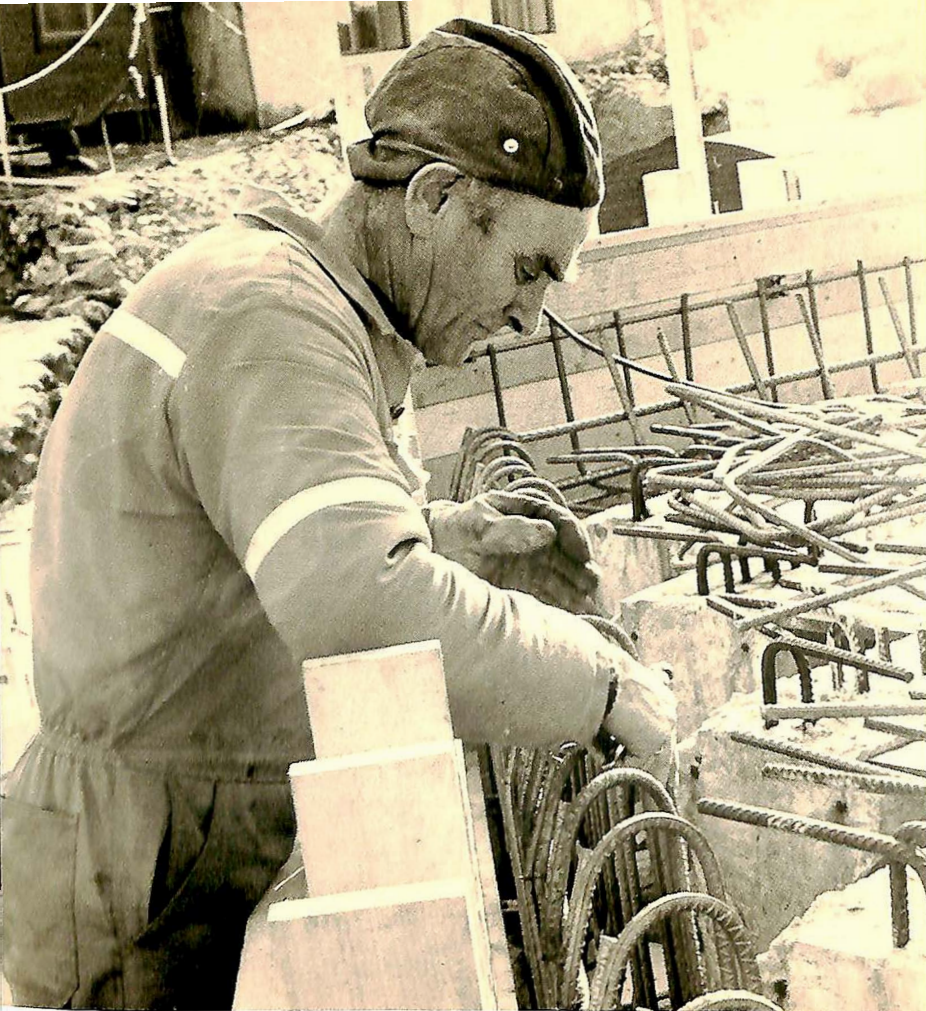
Bjarne Sløre driv med jarnbindingsarbeid på anlegget Eikanger - Ostereidet.
