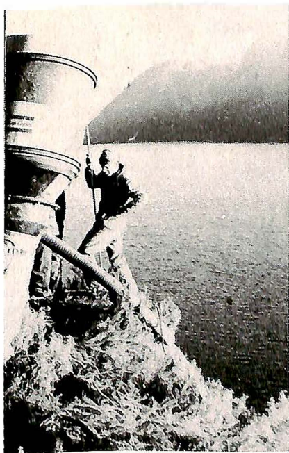
Utsett arbeidsplass på Masfjordvegen.
