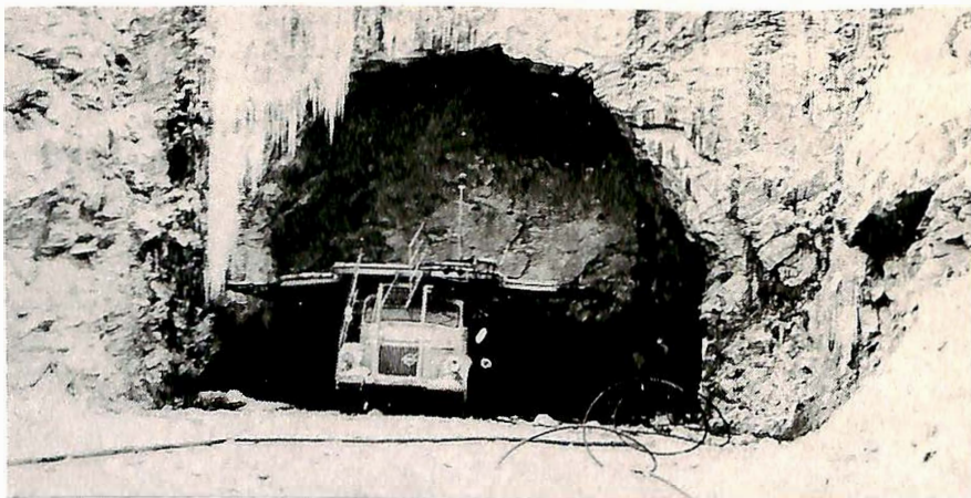
Oppstartning av tunneldrifta på Eikefet.
