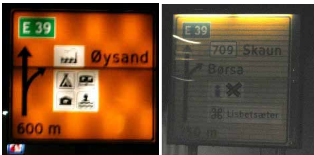
Figur 1.14 Eksempler på innvendig belyste trafikkskilt med dårlig luminansjevnhet.
