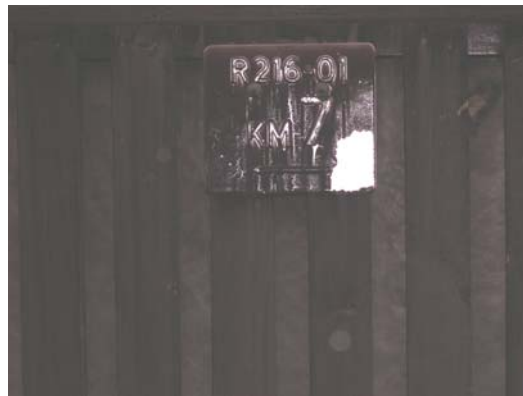
Figur 9: Slike skiltplater som er nærmest usynlige må skiftes ut.
