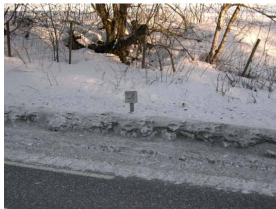
Figur 11: Slik skal ikke en referansestolpe settes opp. 30 cm høy stolpe på skulderkanten er ikke i henhold til retningslinjene.
