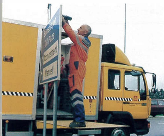
Jon Holmebakken monterer eit nytt skilt. Plattformen på bilen kan heisast opp og ned etter behov. Før sto ein i stige under monteringsarbeidet.
