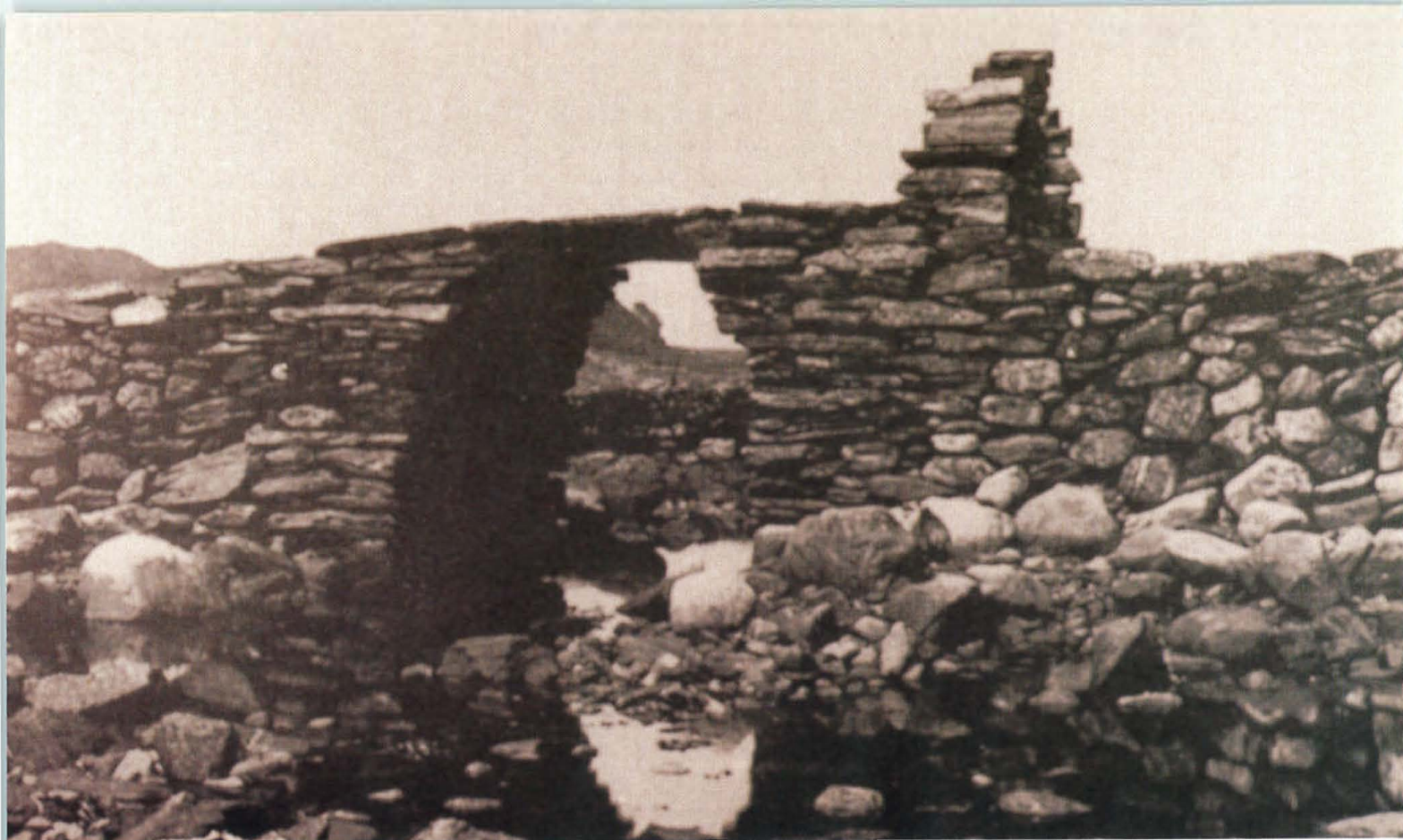
Hjallar bru på Mosterøy. Brua ble revet i 1898.
