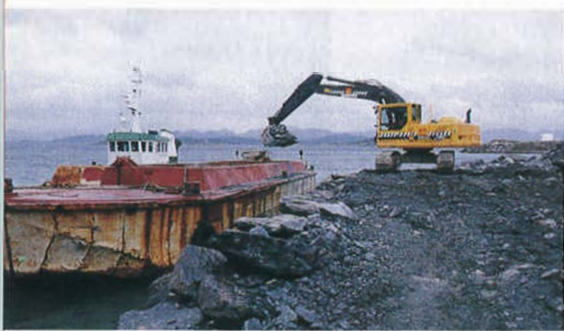
Steinmasser fra tunnelen som har ligget lagret på land i Lervig blir nå frakta ut med lekter og deponert i sjøen.
