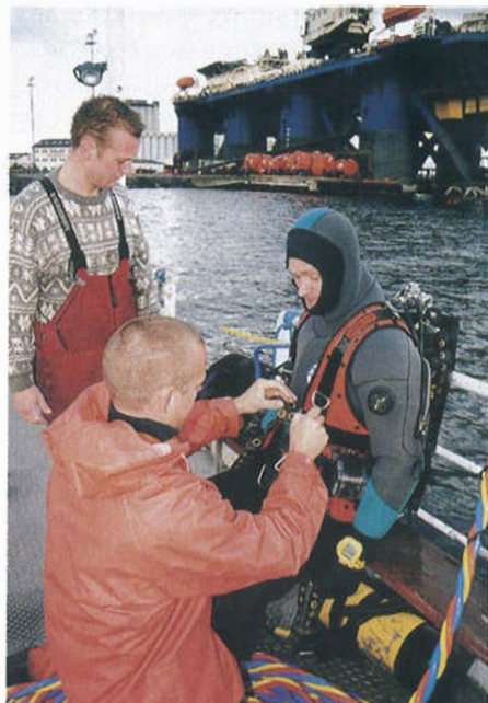
Dykkerne Erik Vrålstad, Eivind Karlsen og Dan Pettersen fra Oslo fikk seg noen arbeidssøker 18 meter under havflata da de tok på seg oppdraget med å legge ut 16000 kvadratmeter polyesterduk for vegvesenet.
