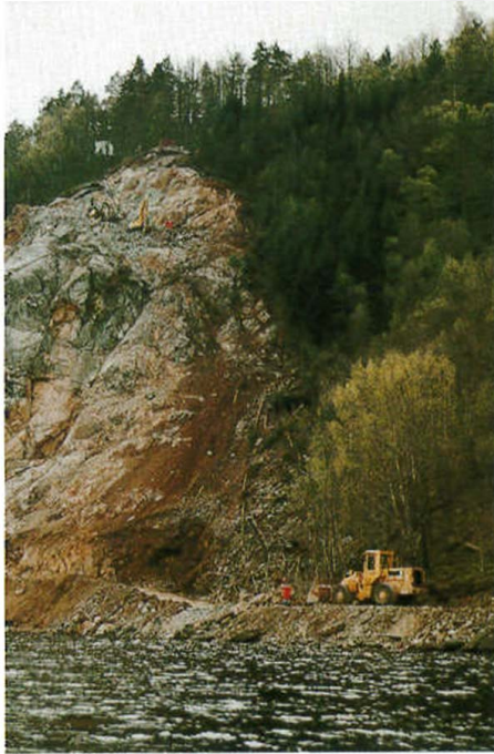
Gravemaskinen og arbeidsfolka jobbar 50 m over vegen og vatnet.
