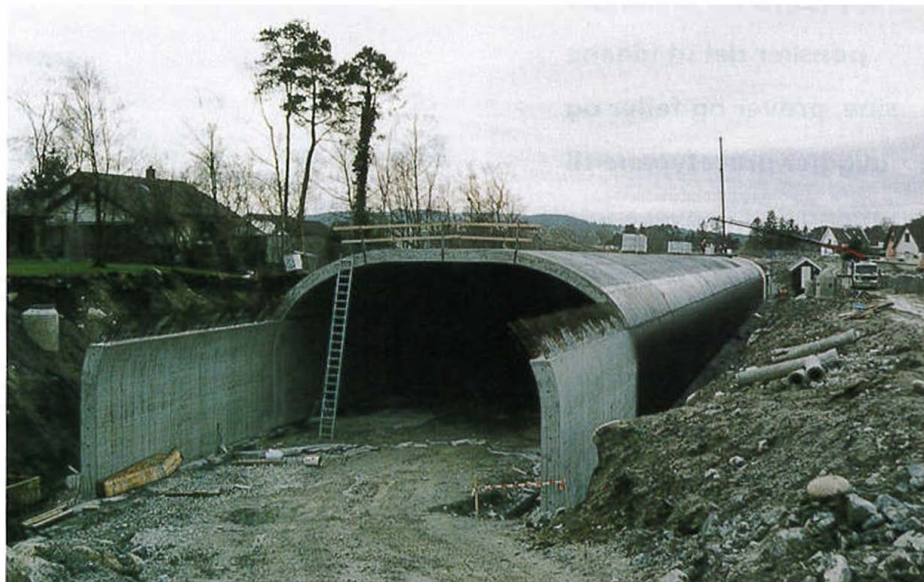
Miljøtunnelen på riksveg 13 vil gjera bummiljøet langs riksveg 13 rolegare og sikrere.
