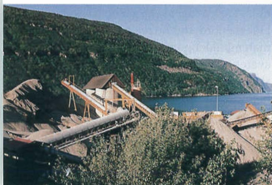
Frå asfaltverket i Jøsenfjorden
