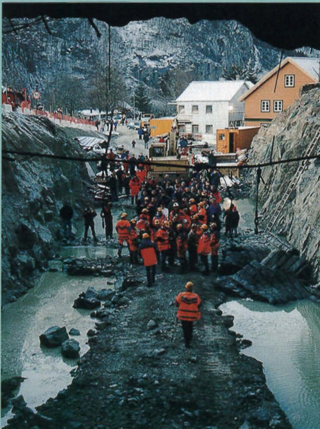
Utsyn frå røysa, etter at tunneltaket var sikra og dei første menneska hadde tatt seg fram gjennom fjellet frå Frafjord til Gilja. Den første var tunnelarbeidar Sveinung Marvik, deretter kom Gjesdal-ordførar Svein K. Søyland, vegsjef Tor Geir Espedal og alle dei andre.
