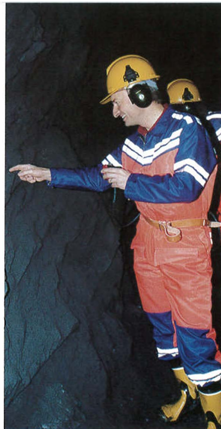
I arbeid med å sjekke fjell i Byfjordtunnelen.
