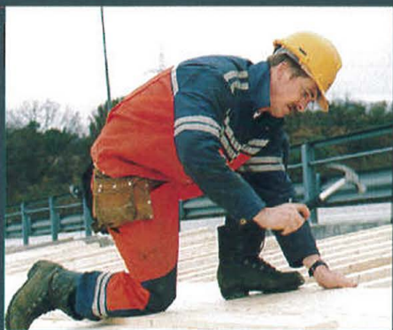
Forskalingsarealet på brua er 2.045 kvm. Her er Ole Gunnar Tvedt i arbeid med forskalingsbord, spiker og hammar.
