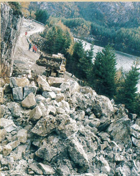
Salva er gått. Ei stor steinrøys er sprengt ut. Vegen skal vera rydda og opna igjen innan to timar.
