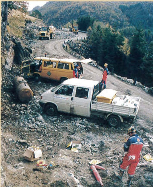
Siste klargjering før sprenging. Borehola er opptil 8 meter djupe.
