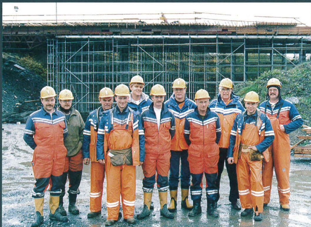
Arbeidarane og anleggsleiarer saman med Vegsjefen og stabsleiarer på Utbyggingsavdelinga framfor brua. Dette var i november, under forskalingsarbeidet på nordre del av brua. Frå v.: Terje Nordmark, Curt Lid, Jon Haugslund, Karl Fredrik Riska, anleggsleiar Kenneth Rott, Ole Gunnar Tvedt, stabsleiar Øyvind Kommedal, Einar Thuestad, vegsjef Chester Danielsen, Odd Helge Johannesen og Terje Kaldekodt.
