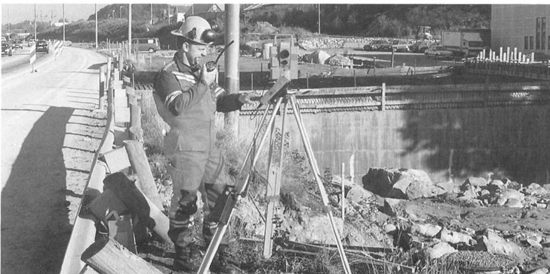
Geir Strømstad i arbeid med sitt avanserte måle- og stikningsutstyr. Bak Geir til høgre, ser me den halvferdige Godeset bru. Her blir det undergang for adkomstveg mellom Godeset og industri- og kjøpesenterområdet på Forus vest.
