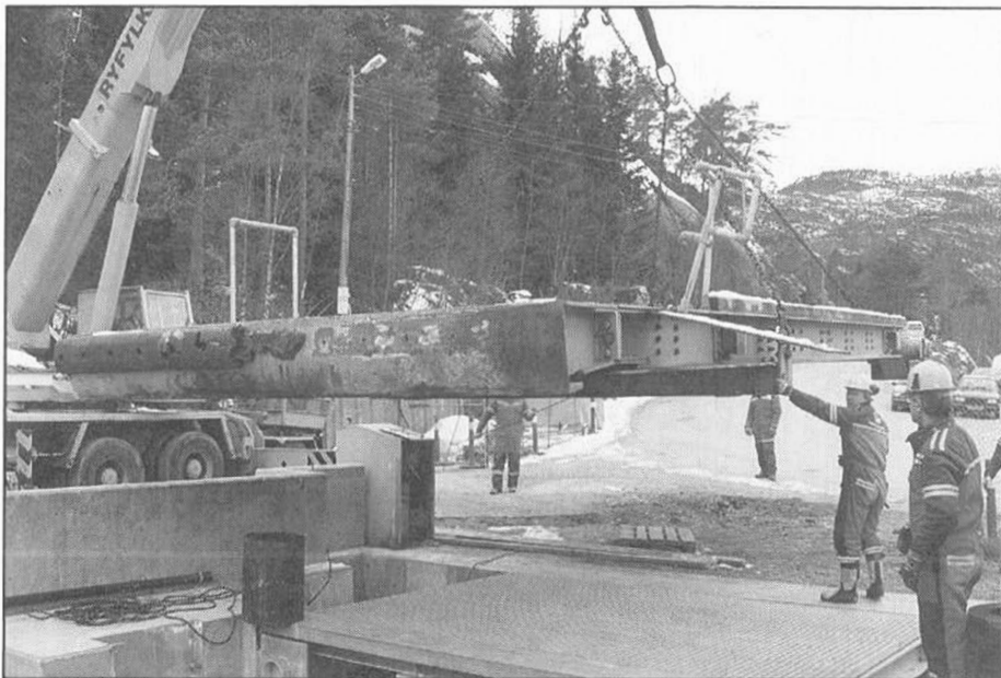
Ferjelemmen blir heist på plass. Den gamle ferjelemmen, som er fire meter brei, blir også brukt på den nye ferjekaia. Men kaia er bygt slik at denne kan erstattast av ein lem på seks meter.
