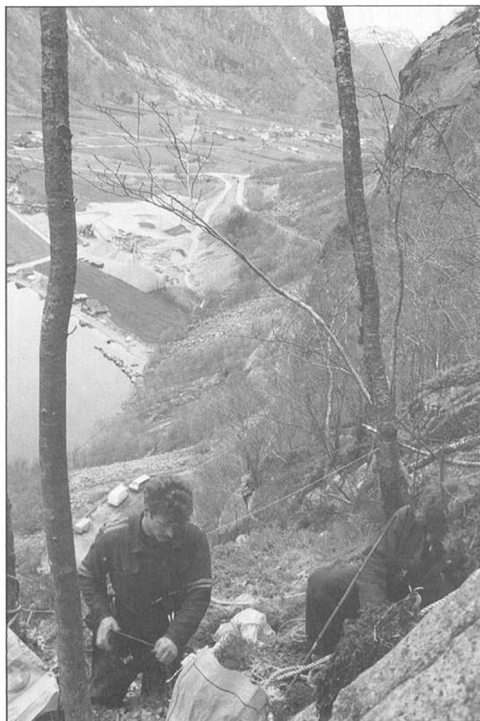
Fleire hundre kubikkmeter stein på veg ned fjellsida under bortsprenging av eit rasfarleg overheng.
