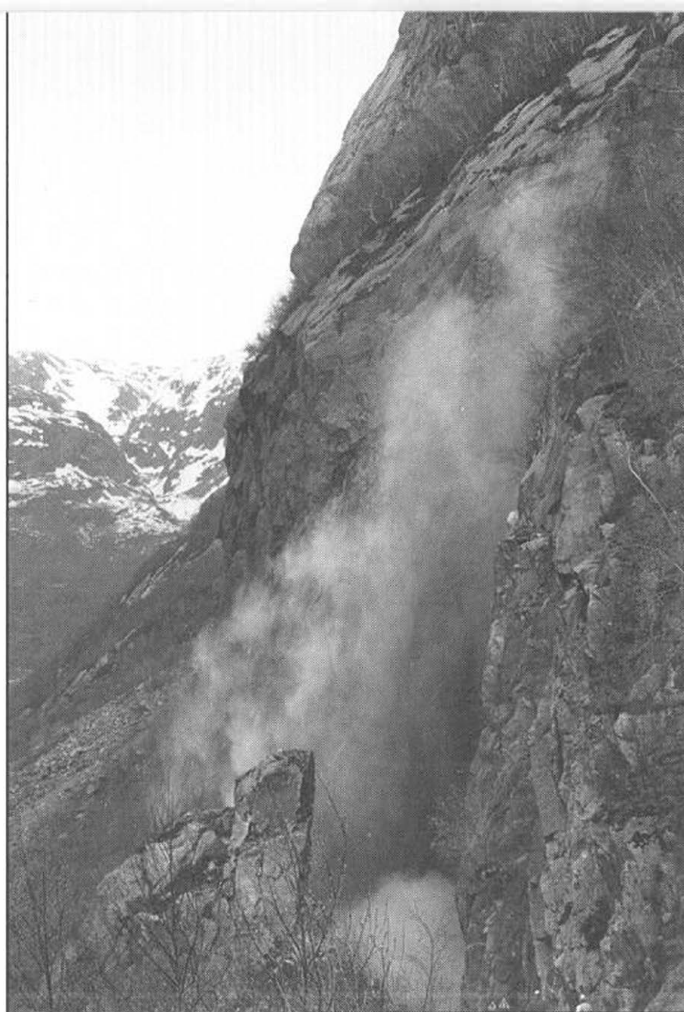
Fleire hundre kubikkmeter stein på veg ned fjellsida under bortsprenging av eit rasfarleg overheng.
