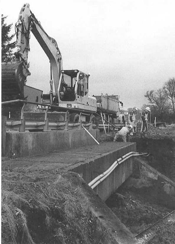
Frå arbeidet med ny gang- og sykkelbru over Njåbekken.
