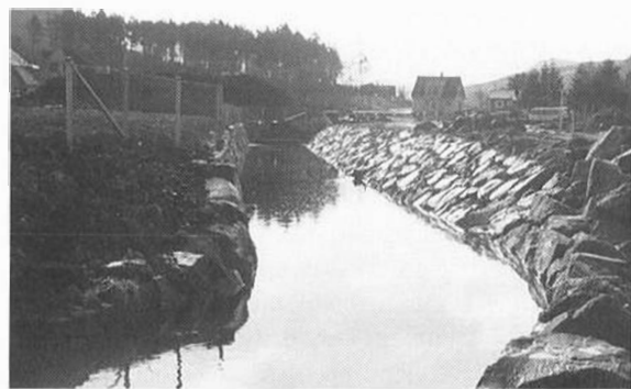
Her ser vi Bråsteinskanalen omlagt med plastring.
