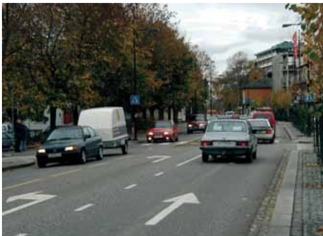
Nedre Langgate med ny utforming, venstresvingefeltet er ikke i bruk
