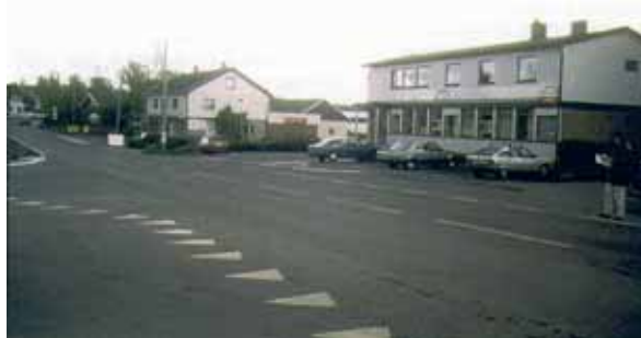
Ask i førsituasjonen. Foto: Statens vegvesen Akershus
