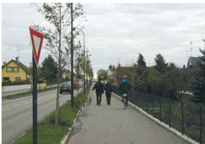
Gang- og sykkelvegen langs Valløveien
