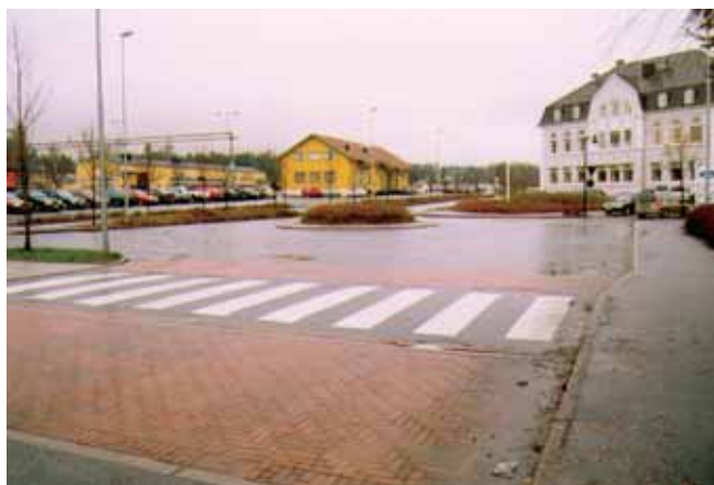
Ramper med marktegl i Drammensveien.
