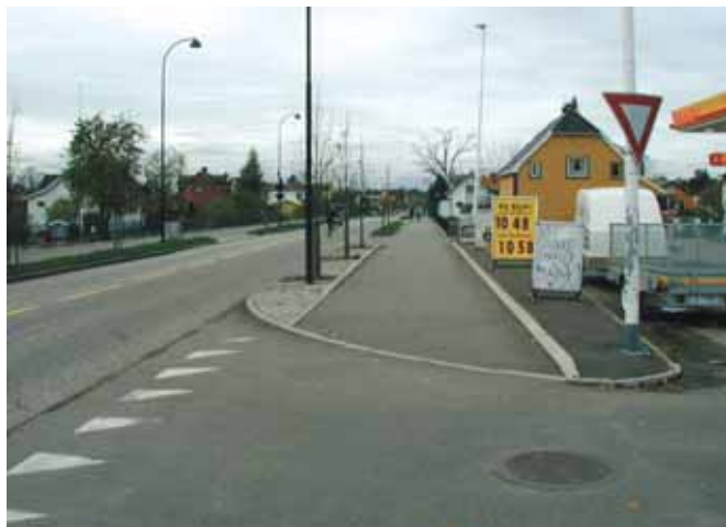
Avkjørsel fra Valløveien - av trafikktekniske hensyn ville en bedre plassering av skiltet vært i rabatten mellom gang- og sykkelvegen og Valløveien
