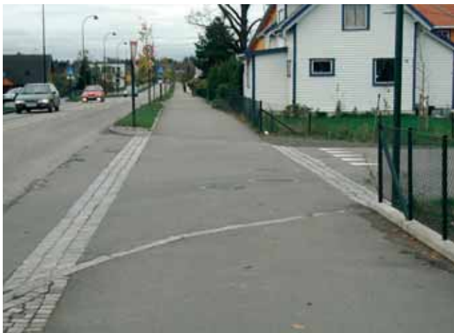
Kryss med sideveg til Valløveien. Slik det er merket opp på vegen gjelder vikeplikten egentlig for gang- og sykkelvegen og ikke for Valløveien. Slik er det ikke ment. Dette gir en uklar og dermed mulig farlig situasjon
