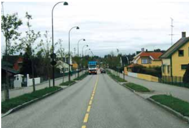
Valløveien har mange avkjørsler. Foto: Odd Nygård
