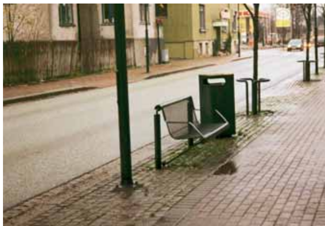
Uheldig plassering av benker ved sykkelstripa. Foto: Amund vik
