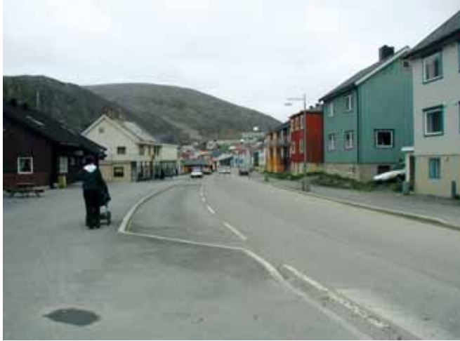
Parkeringslommer langs miljøgata i Kjøllefjord
