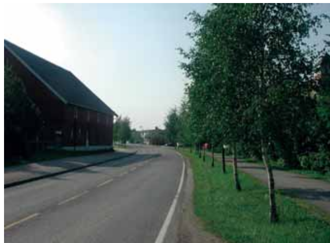
Kantstein og fortau på den ene siden av veggen, og grøft og gang- og sykkelveg på den andre side. Foto: Jon-Olav Haugstulen
