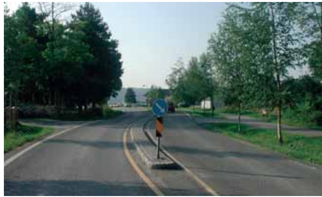
Sideforskyvning i det søndre endepunktet. Foto: Jon-Olav Haugstulen
