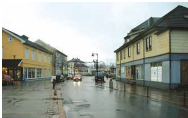
Materialslitasje og vannansamlinger.
