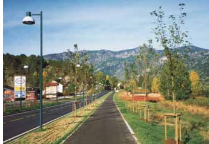
En god løsning i ytre sone, er kjørebane avgrenset av kantstein og beplantning på hver side, og gang- og sykkelveg utenfor plantefeltene. Gode eksempler på denne løsningen er Batnfjordsøra, Valløveien og Flå. Foto: Odd Nygård
