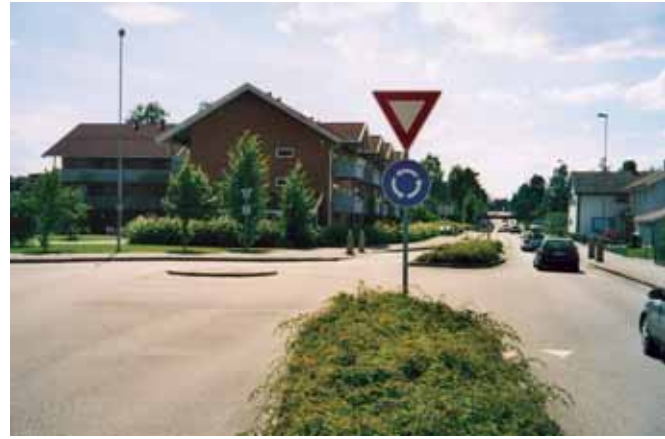
Rundkjøring i Rådhusgata med dårlig avbøyning. Foto: Bjørn Haram
