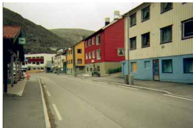
Fortau og kantsetting regulerer kjøremønsteret
