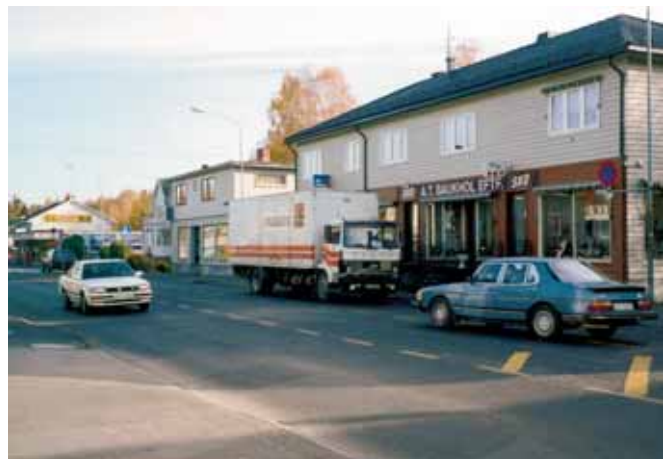
Storgata før ombyggingen
