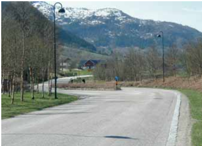
Endepunkt med sideforskyvning i Batnfjordsøra
