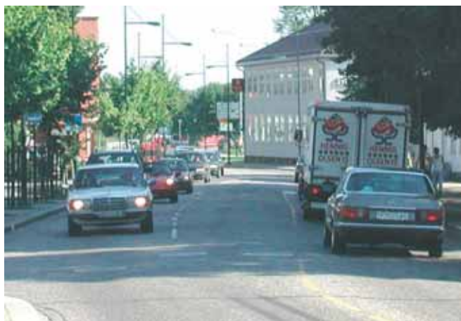
I miljøgater bør det vises stor tilbakeholdenhet med venstresvingefelt. Hvis venstresvingefelt ikke kan unngås, bør det vurderes om venstresvingefeltet og rettfram feltet begge kan ha en bredde på 2,75 m. Nedre Langgate, Tønsberg Foto: Odd Nygård
