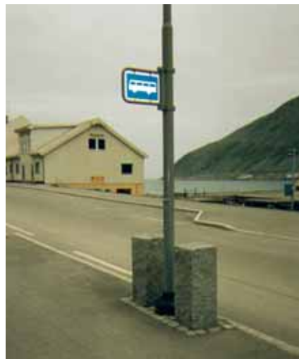
Lysstolper med kraftig beskyttelse mot brøyteskader
