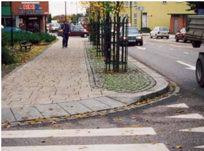
Brede fortau med fin nedsenk mot kjørebanelen. Foto: Amund Vik
