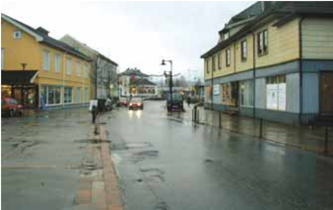
Materialslitasje og vannansamlinger
