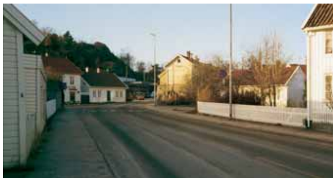
Førsituasjonen i Løkkegata. Foto: Øystein Aalen
