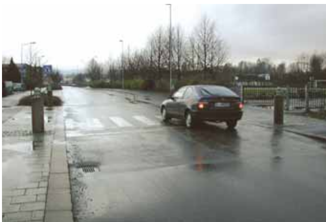
Dårlig avrenning mot sluk fra fortauet.
