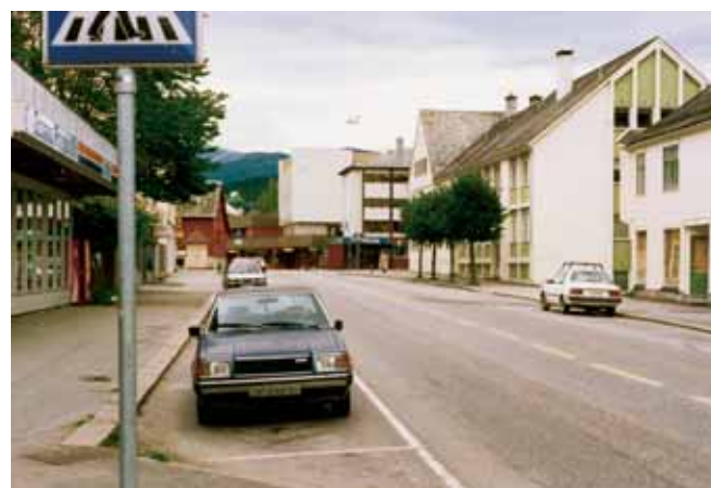
Uttrågata før ombyggingen. Foto: Kalve og Smedsvig AIS
