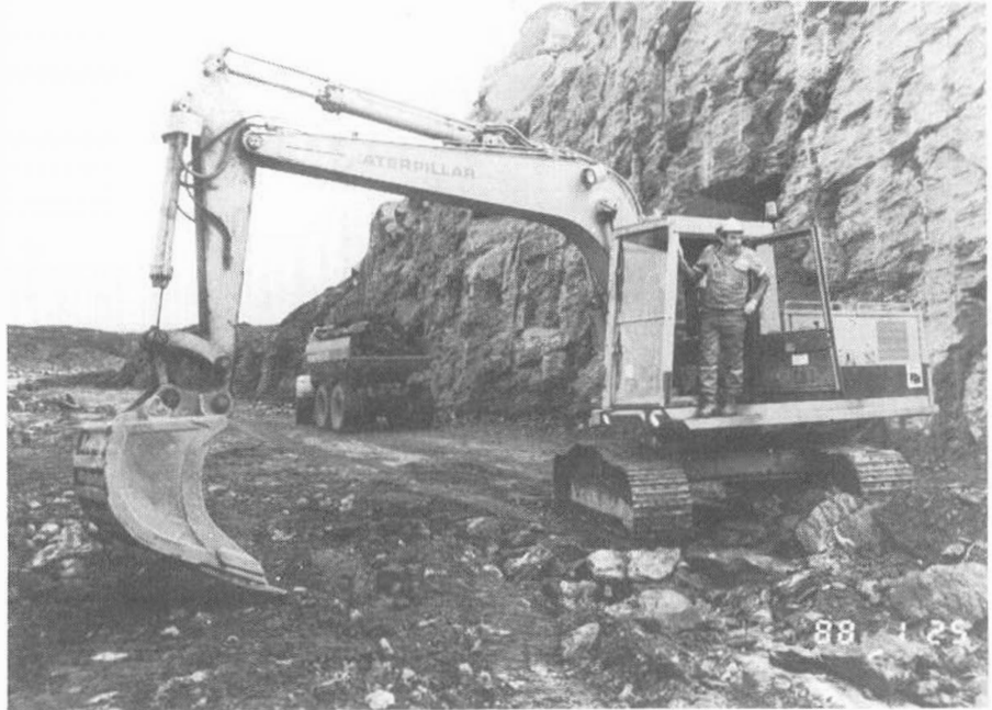
Fra anlegget på Ognøy. Vegvesenets gravemaskin, Cat 315, med fører Olav Tørresdal.
