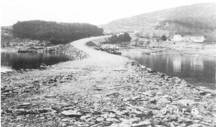
Parsell av den nye rv. 512 ved Susort fra fyllinga og innover mot land.
