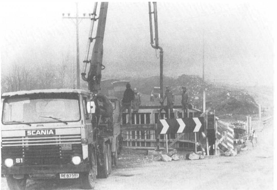
Frå arbeidet med Øvre Hetland bru, som var eit av anlegga der eigenregikalkyle blei brukt.
