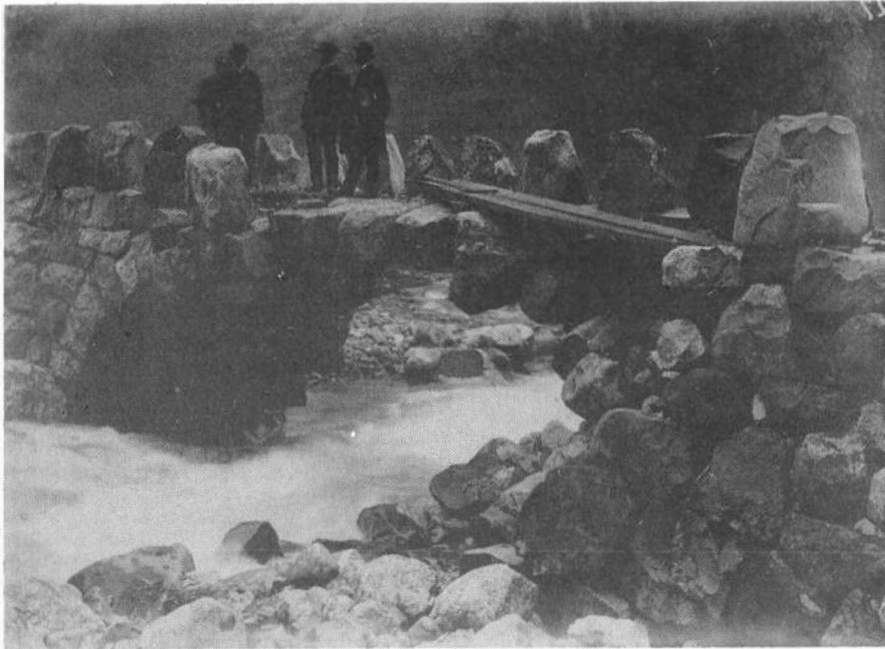
Dette motivet viser Gya bru, Heskestad etter at den er blitt sterkt ramponert av en flom i 1898.
