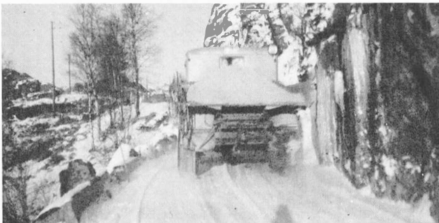
Eikelistien på rv 44 mellom Egersund og Hauge før utvidinga i 1958. Veggen er typisk for den standarden som var på ein stor del av vegane i sør-fylket til langt inn i 1960 åra.
