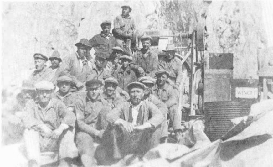
Dette biletet viser arbeidslaget som Alfred Lillehammer var med i under anlegget av brua over viadukta i Suldalsporten 1938. Første rekkje frå v.: Gunnar Kvamme, Erik Helganes, ukjent, Alfred Lillehammer, ukjent, Lars Lillehammer, Tor Djuvik og Odd Tveit. Andre rekke: Magne Ås, Aslak Brustveit, Johan Andersen (frå Fyresdal), ukjent, Odd Bjerga, Sakkestad (formann ukjent), ukjent og Georg Førre. Bak: Ukjent, Martin Bratland. (Kjenner nokon dei personane som er ukjent?)
