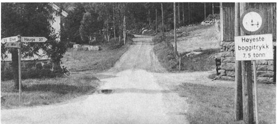
På fylkesvegnettet er det fremdeles mange veger med dårlig bæreevne. Dette skiltet på fv 1 angir et boggitrykk på 7,5 tonn. Vanligvis er tillatt boggitrykk 1 1/2 gang høyere enn akseltrykket. I dette tilfellet vil det si at akseltrykket er 5 tonn. Med boggitrykk menes den vekten som er tillatt for biler med 2 akslinger som har en avstand på mellom 1,20 og 2 meter.
