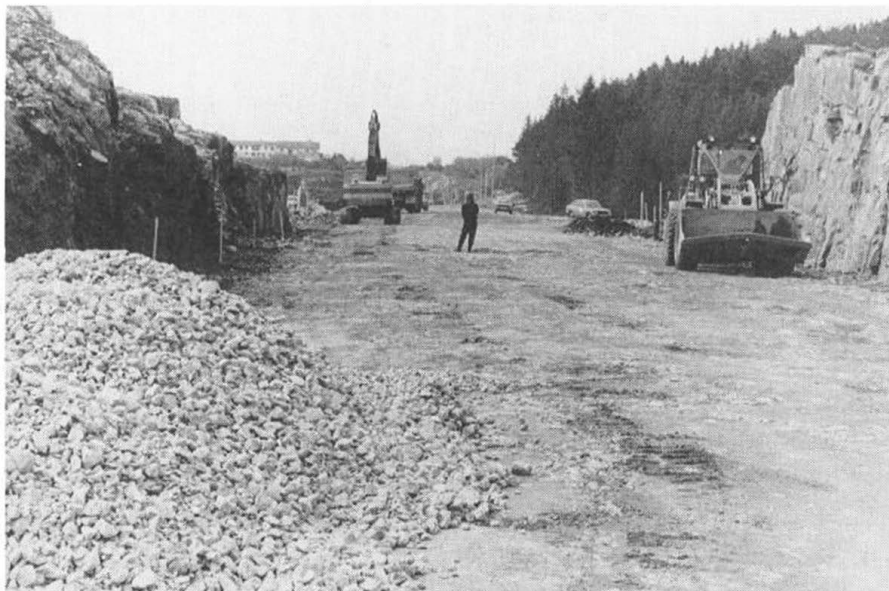
Billedet viser et forsterkningslag, der det har vært stor anleggstrafikk. Vi har da fått nedknusing og tilgrising av det øverste lag, som da blir fjernet og erstattet med knust masse av den typen som vi ser til venstre på bildet.
