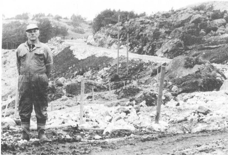
Leiv Kvæstad ved avkøyringa fra E76 til den «nye» vegen til Fjon i Sveio. Våg-Sunfør blei hans siste anlegg. No vert det tid til litt gardsdrift att.
