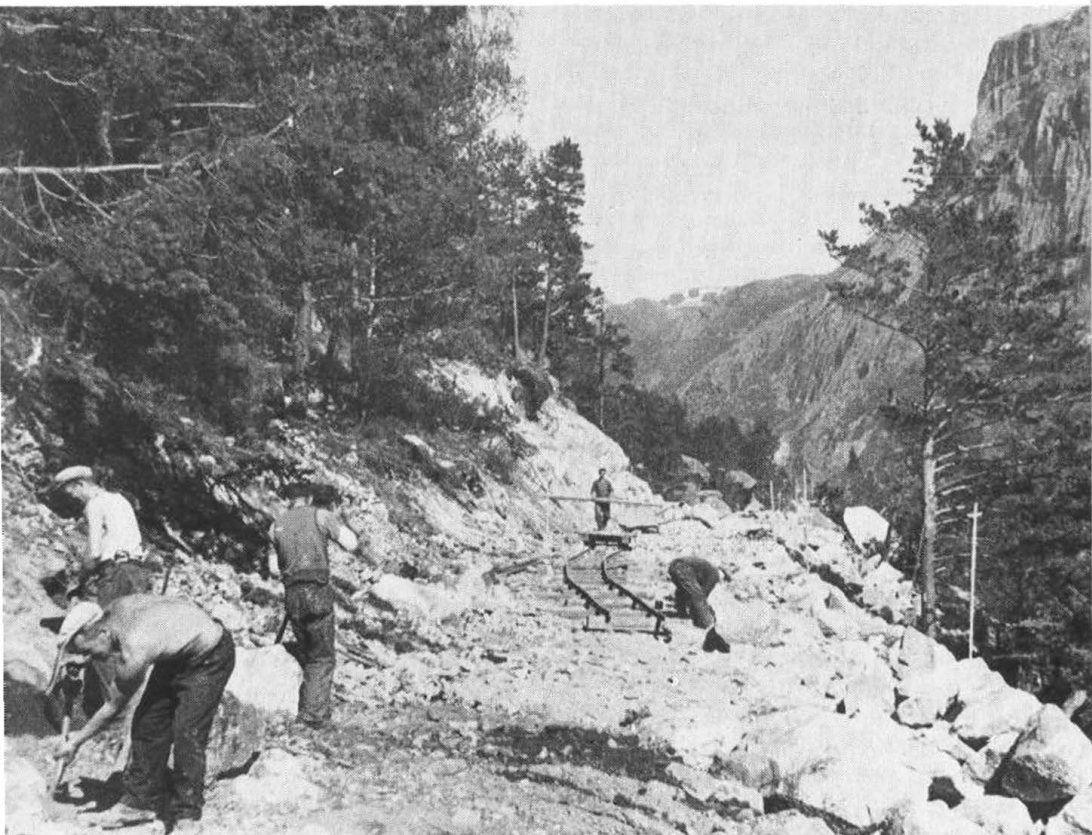
Fra arbeidet med Ryfylkevegen langs Tysdalsvatnet.
