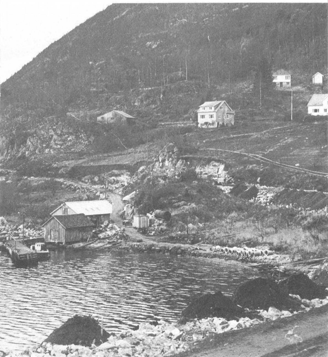
Veganlegget Vindsvik–Nesvik. Anleggsarbeid i gang i Ytre Eiane.
