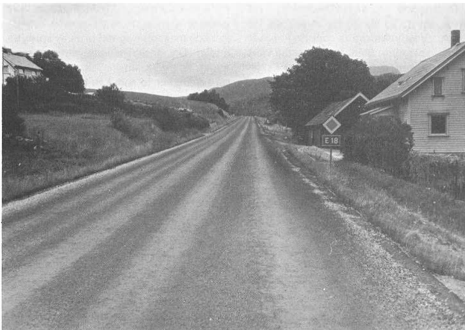
Vi ser her den nye overflatebehandlingen på Bollestad ved Vaule bru på E-18. Vi ser at bitumenen trenger opp i hjulsporene og at kjørebanelen er svartere enn helt ute på kanten.
