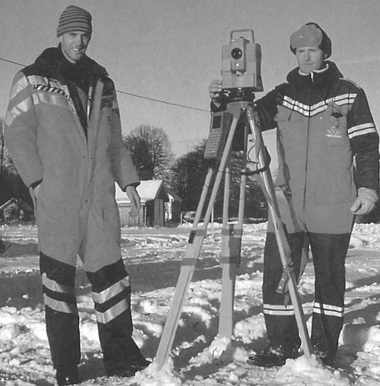
Gert Albrecht og Audun Aas er i full sving med stikking av nye E 18 over Nedenes.
