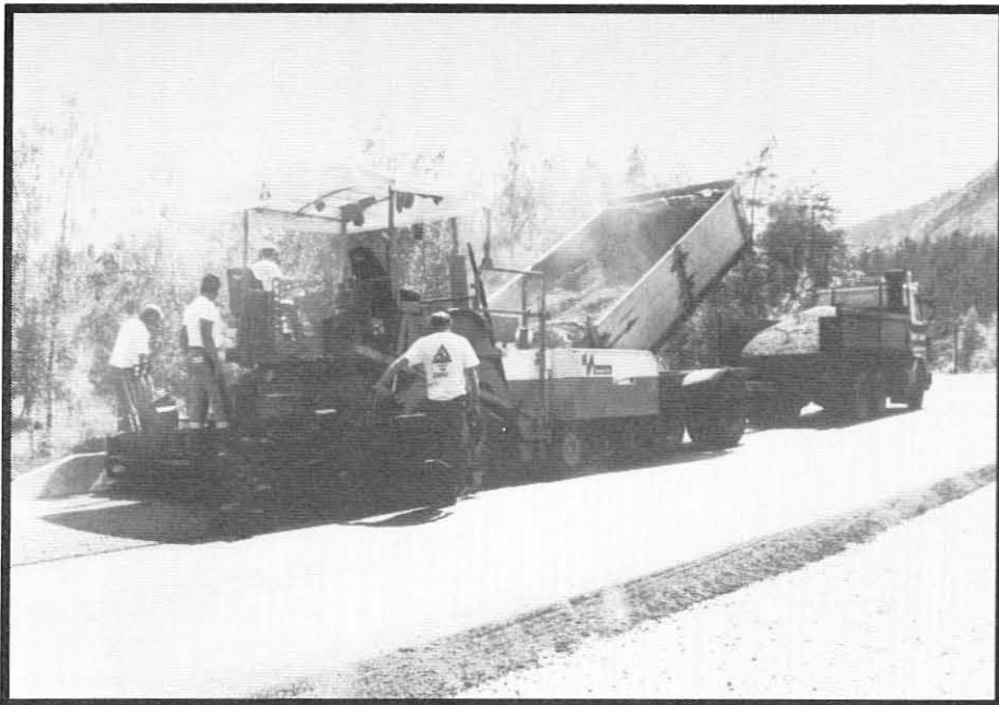
Store asfalteringsarbeider pågår i hele sommer.
