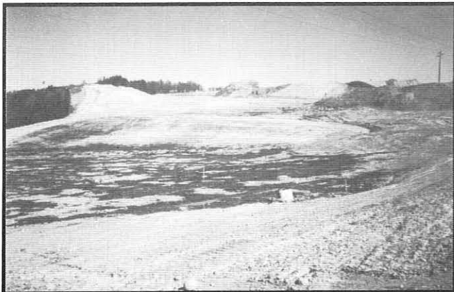
Svære leirfyllinger og bakkeplanering på E68.
