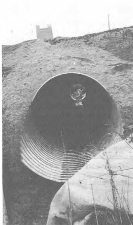
På rekordtid var den nye stikkrenna på plass.
