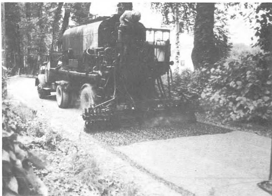
Singelen blir oversprøytet med asfaltløsning som holder en temperatur på + 120°C.
