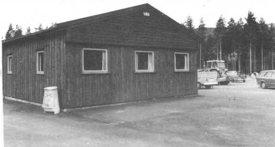
Kontorbygget og glimt av området rundt.
