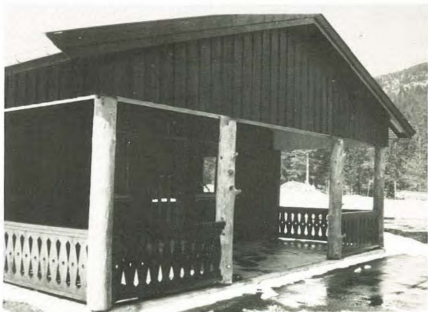
Valle vegstasjon, kontorinngang.
