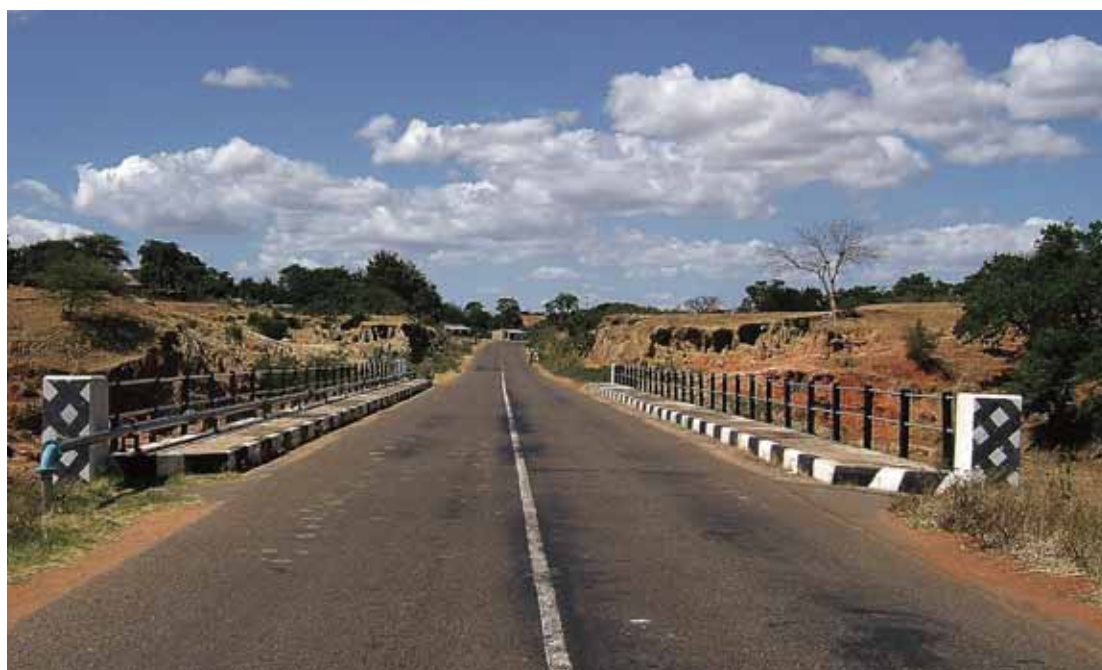
Bruhjelp til Zambia: Statens vegvesen skal sende en bruekspert til Zambia som etter planen skal være på plass i Lusaka fra nyttår. (Foto: Otto Kleppe)
