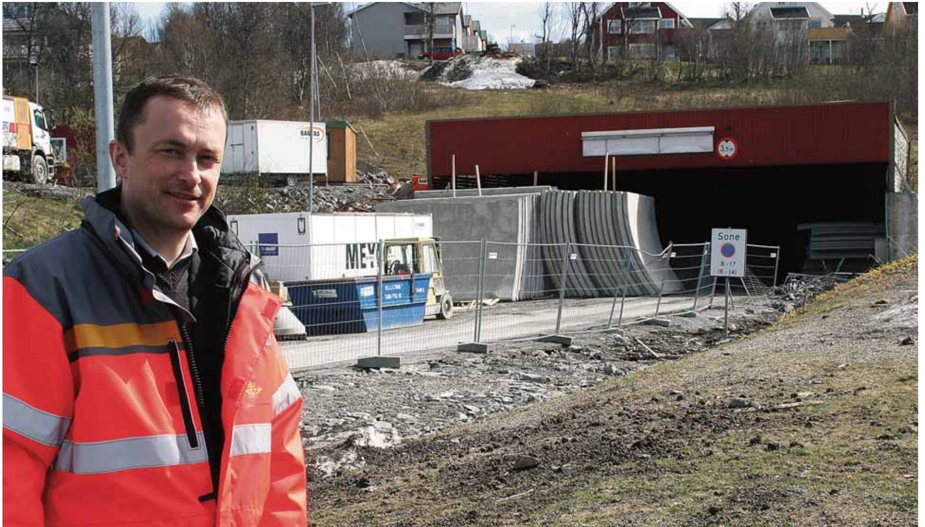
Mangler mottak: Distriktssjef Nils Arne Johnsen, etterlyser norsk løsning på håndtering av bromerte flammehemmere som nå fjernes fra Langnestunnelen i Tromsø. (Foto: Anne Hjort-Larsen)
