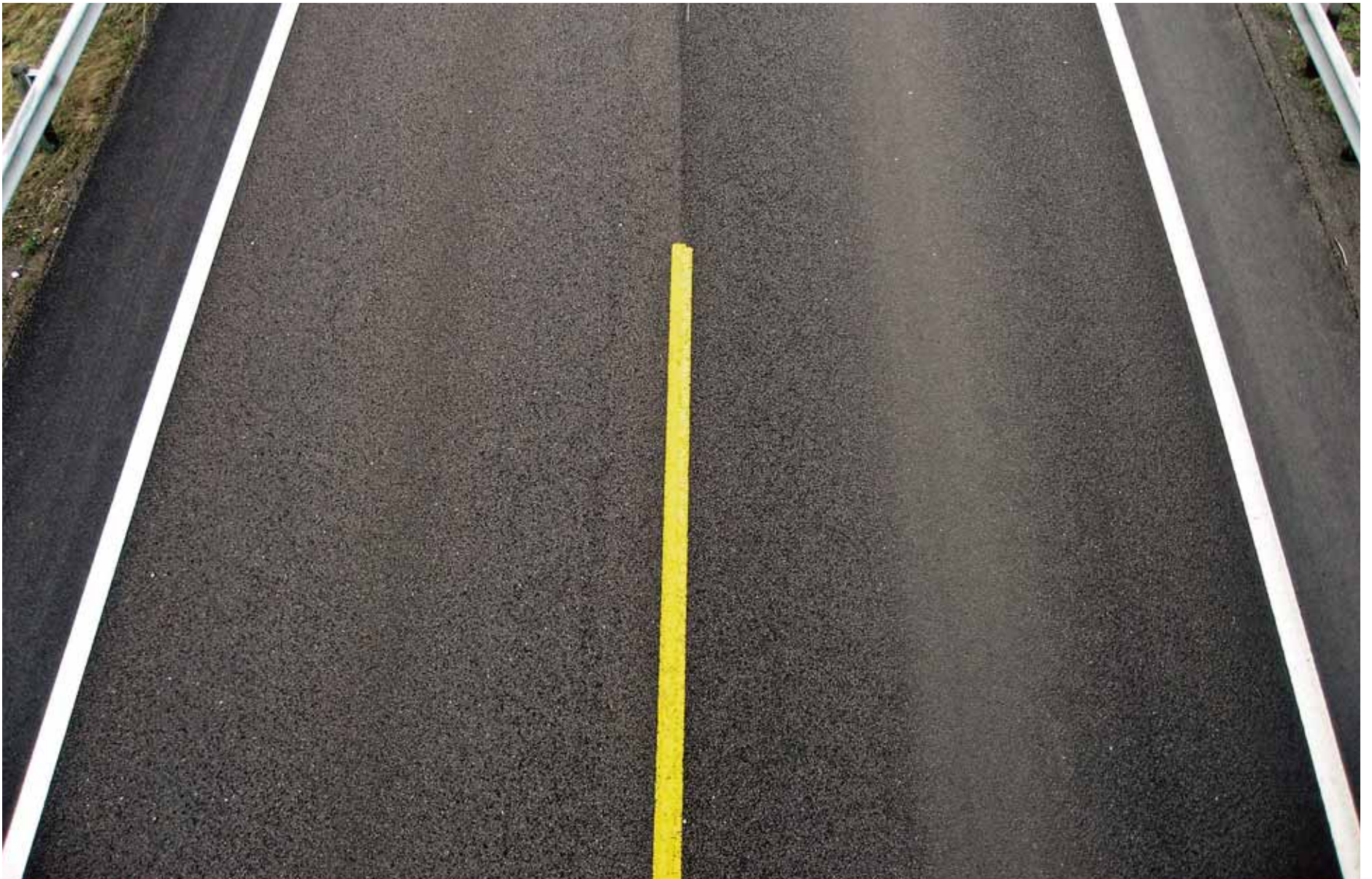
Hviskende asfalt: Statens vegvesen tester ut ulike dekker som skal gi lite lyd fra seg. Whisperfalt, som er lagt på E6 ved Espa, gir gode resultater. (Foto: Torleif Haugødegård)
