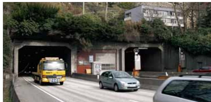
Førsteplass: Med fem millioner ATK-kontrollerte kjøretøy i året er E16/E39 Fløyfjellstunnelen i Bergen på norsktoppen. (Foto: Geir Brekke)
