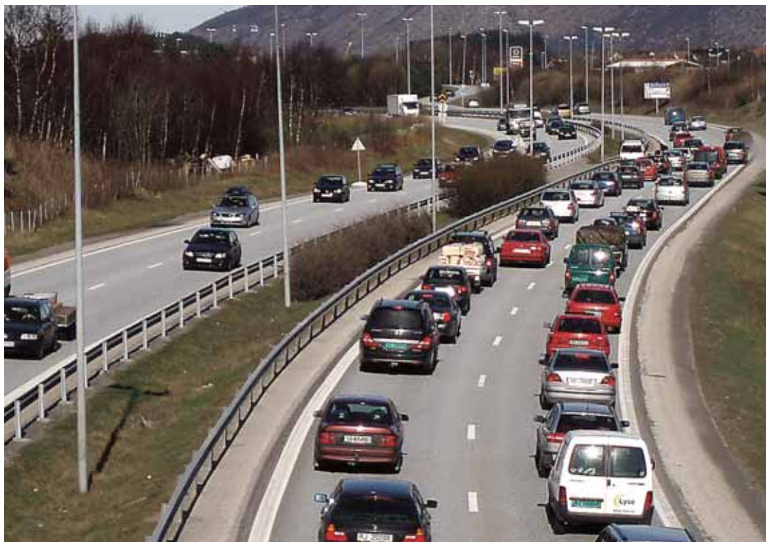
Tett trafikk: Den 6,5 km lange strekningen på E39 mellom Hinna og Stangeland har fått midtrekkverk. (Foto: Tor Oscar Walskaar).
