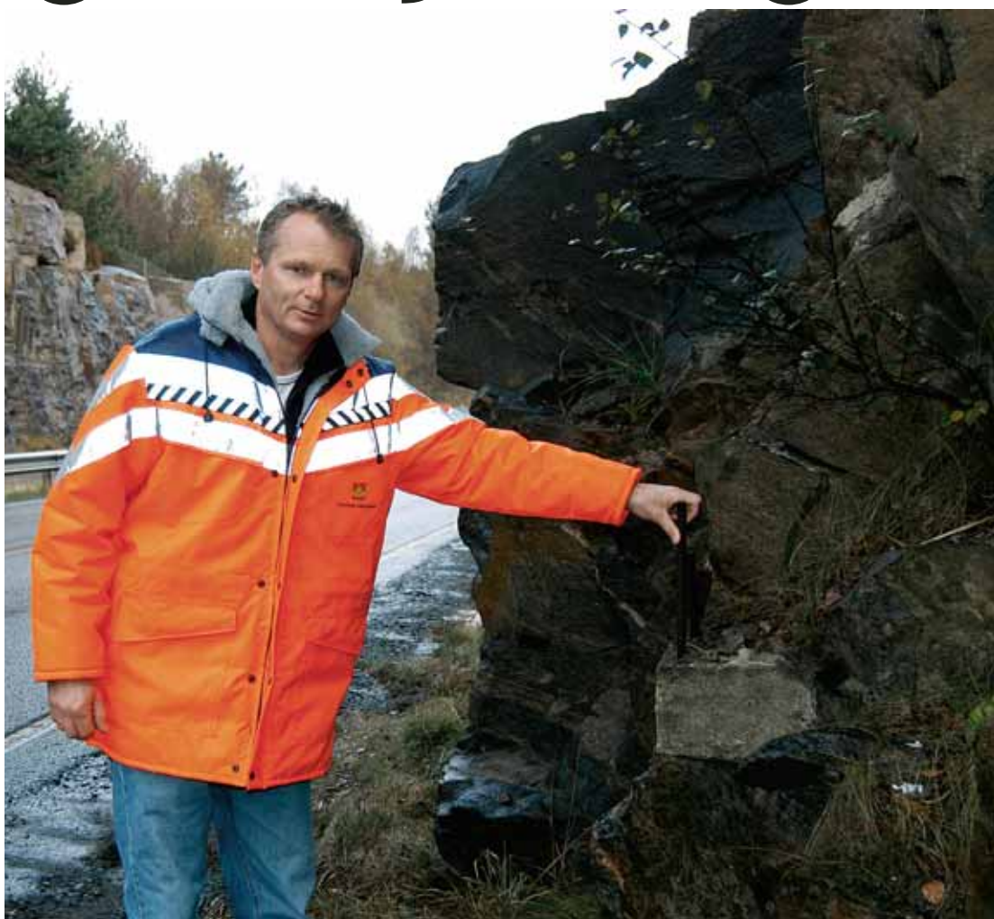
Farleg fjell: Tor Høyland i Statens vegvesen ved ein farleg fjellknaus på ein veg der det seinare er gjort sikrings-tiltak etter trafikksikrings inspeksjon. (Arkivfoto: Geir Brekke)
