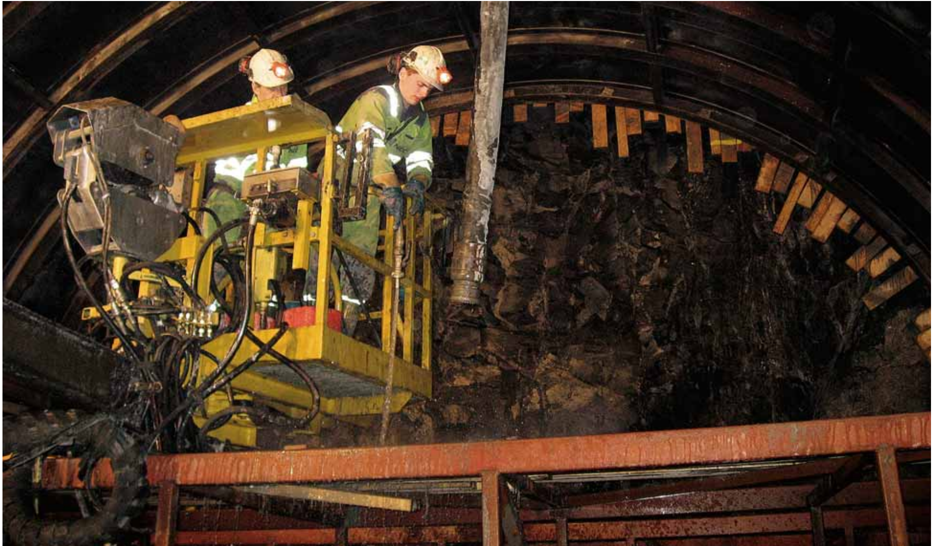
I full gang: Full utstøyping av tunnelprofilen pågår i Finnfasttunnelen. (Foto: Anne-Merete Gilje)
