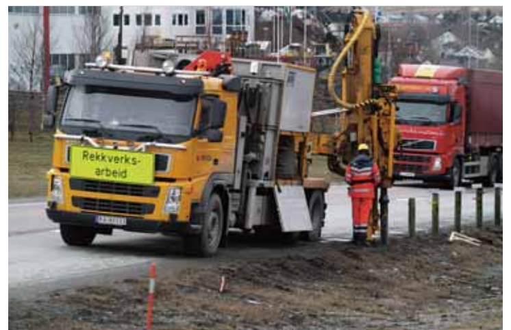
Lønnsomt: Her tryller Statens vegvesen fram midtrekkverk for å hindre tragiske møteulykker på E6. (Foto: Knut Opeide)
