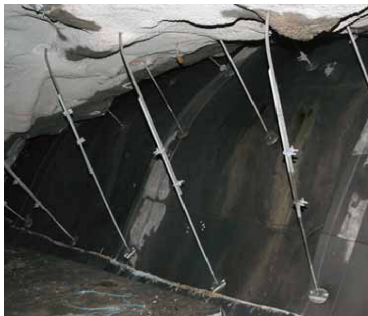
Flere leiresoner: Løkentunnelen må også ettersikres. (Foto: Kjell Wold)
