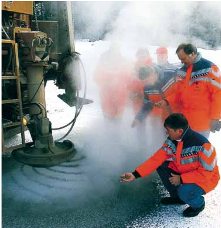
Smart salting: Statens vegvesen skal forske på hvordan de kan redusere saltforbruket og bruke mindre miljøskadelig salt i sårbare områder, samtidig som det blir trygt å kjøre. (Arkivfoto: Statens vegvesen)
