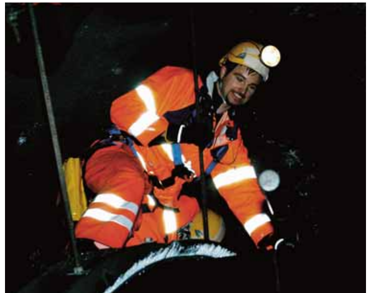
Betre plass: I nyare tunnelar er det plass til, inspektørar bak kvelven. (Arkivfoto: Kjell Wold)
