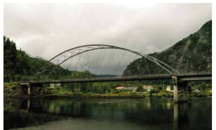
Einaste i landet: Bolstadstraumen bru i Hordaland er den einaste riksvegbrua i landet bygt etter nettverksbogeprinsippet. (Arkivfoto: Geir Brekke)
