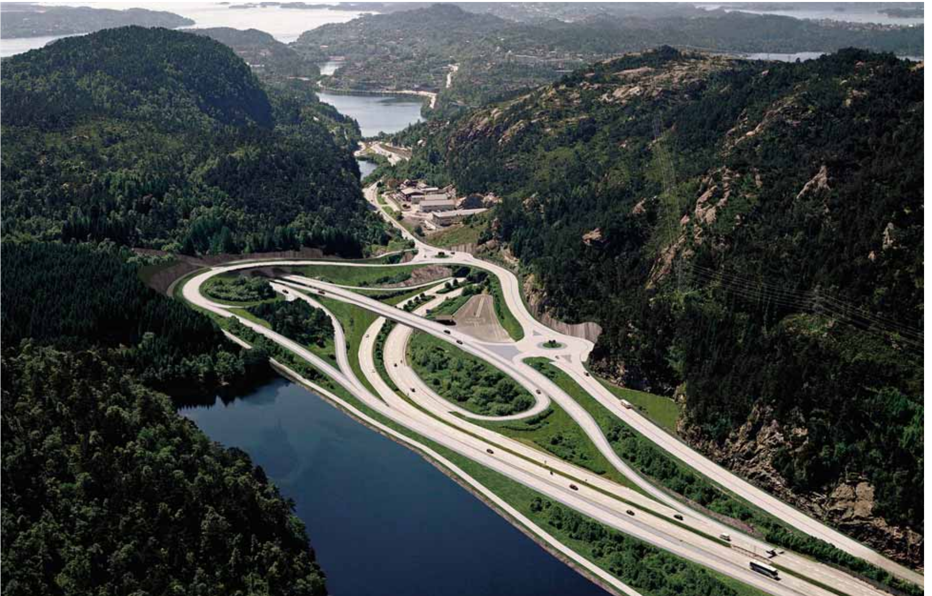
Krys i vatnet: Andre byggjesteg på Ringveg vest er eitt av dei mest aktuelle prosjekta i Bergenspakke 2. Her frå fylling med tilkopling til Ringveg vest i Liavatnet. (Fotomontasje: Norconsult)
